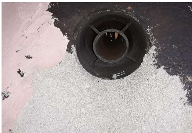
Recuperação superficial com aplicação de concreto denso Thermbond e aplicação de Silplate no bocal F.
