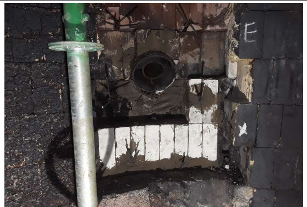
Montagem do revestimento de tijolos isolantes no bocal E.
