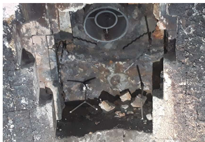
Demolição do refratário do bocal C.
