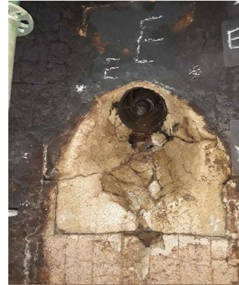
Bocal E antes da intervenção.
