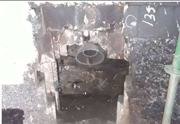
Demolição do refratário do bocal C.
