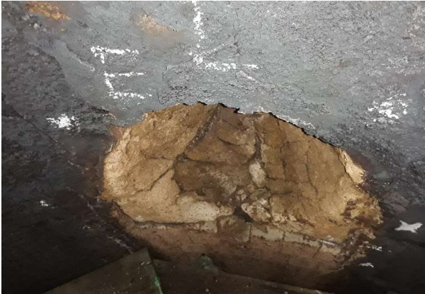
Bocal E antes da intervenção.
