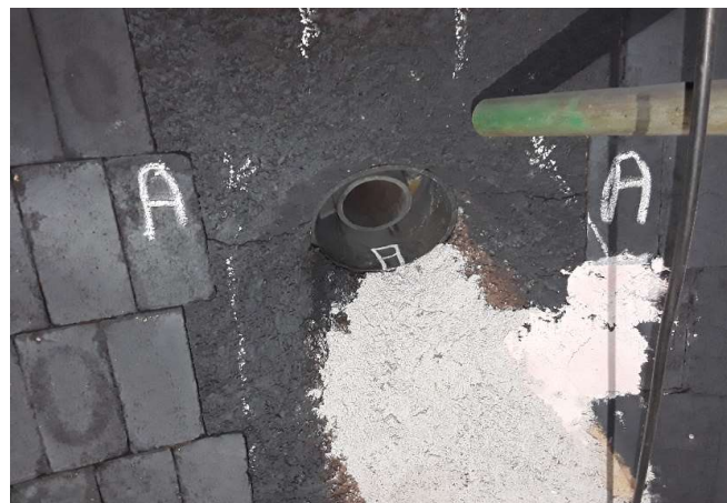
Recuperação do refratário do bocal A com concreto denso Thermbond.
