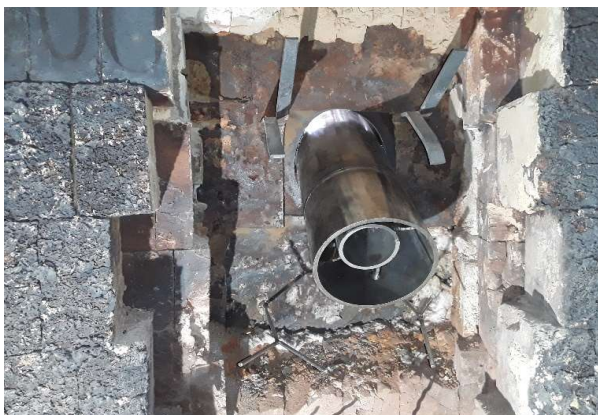
Demolição do revestimento refratário do bocal D.
