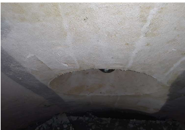
Aplicação de concreto denso Thermbond para recuperação superficial após recomposição do refratário no bocal E.
