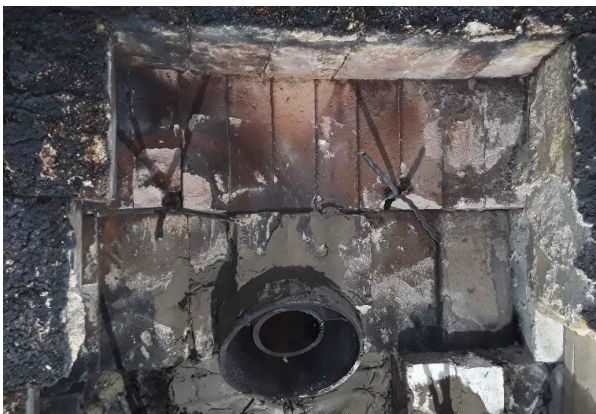
Demolição do revestimento refratário do bocal E.
