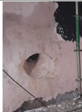
Bocal C após recomposição do revestimento refratário e aplicação da massa Silplate.
