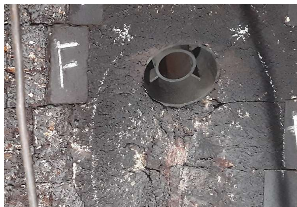
Bocal F antes da intervenção.
