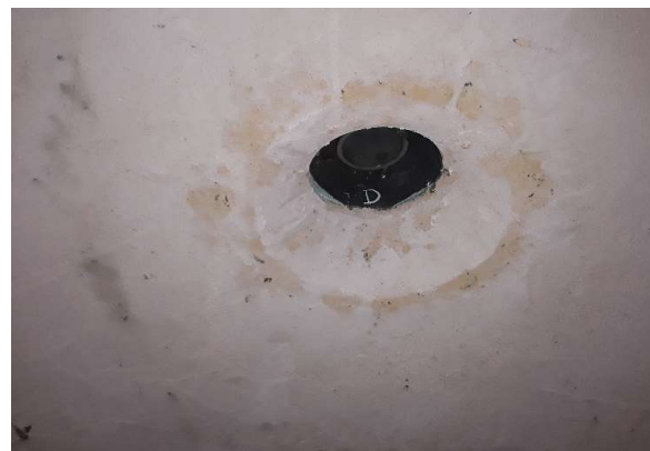
Bocal D após recomposição do revestimento refratário e aplicação da massa Silplate.
