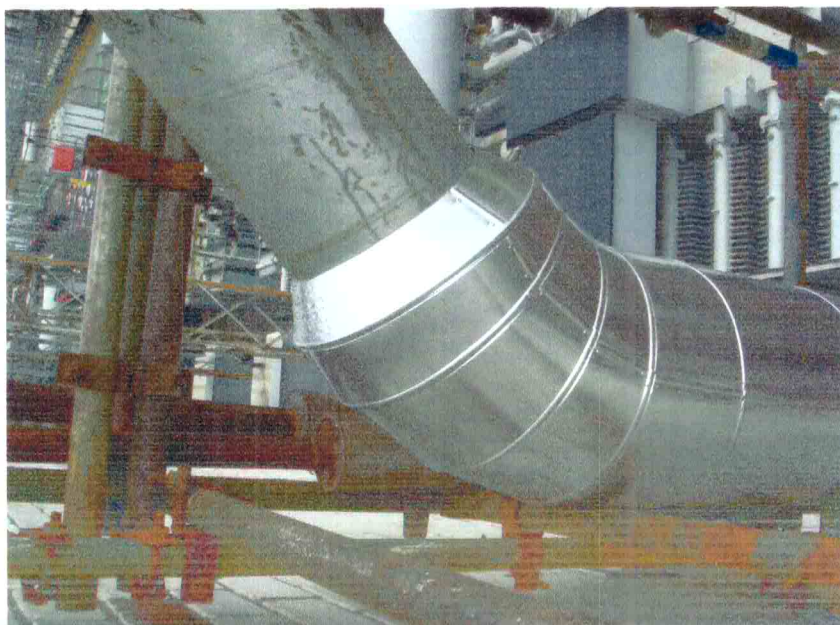
FOTO 03 – APLICAÇÃO DA CHAPA ALUMÍNIO
