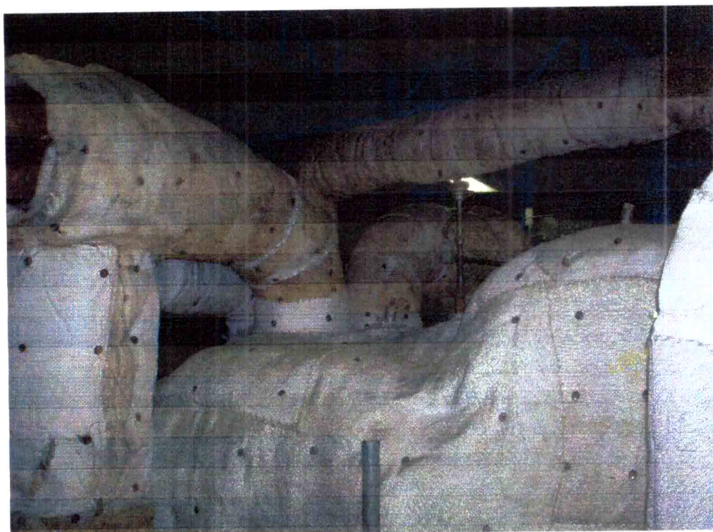
FOTO 01 – APLICAÇÃO 3ª CAMADA DE ALMOFADAS NO TG-5301.
