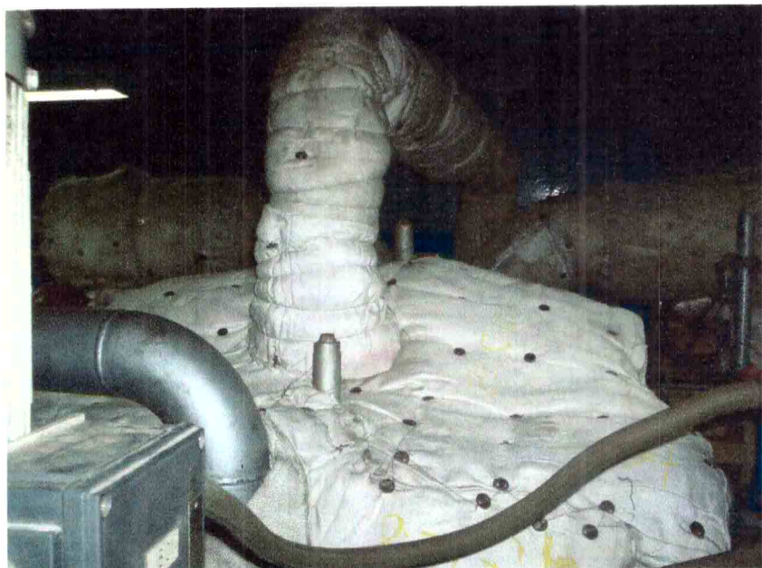
FOTO 06 - APLICAÇÃO DA 1ª CAMADA COM A LINHA DE 3" .
