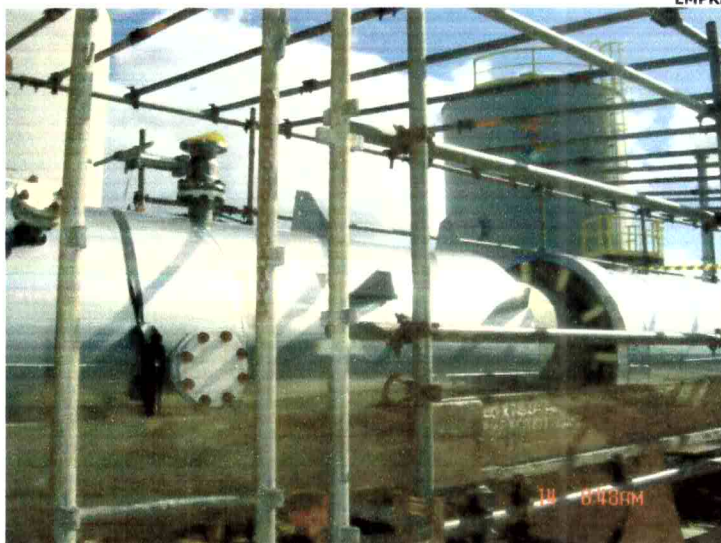
Foto 3 – Detalhe da montagem do revestimento sobre os espaçadores e fixação com borrachas
