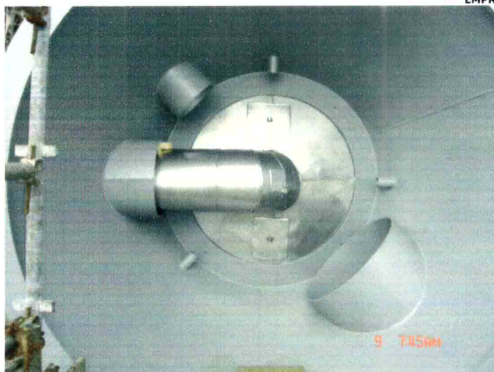
Foto 5 – Detalhe da montagem do boleado inferior
