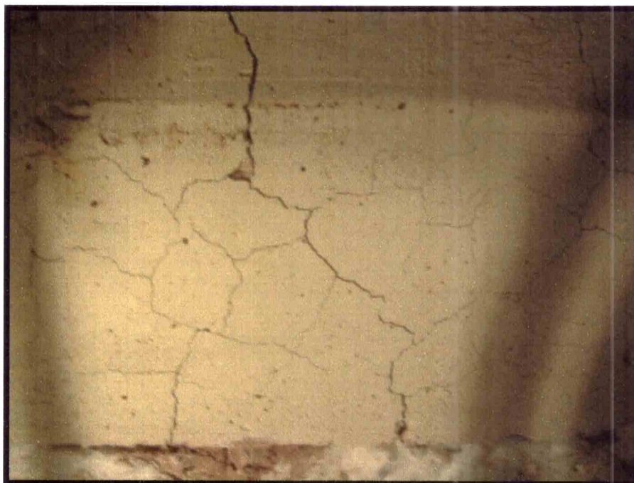
Trincas no concreto da transição
