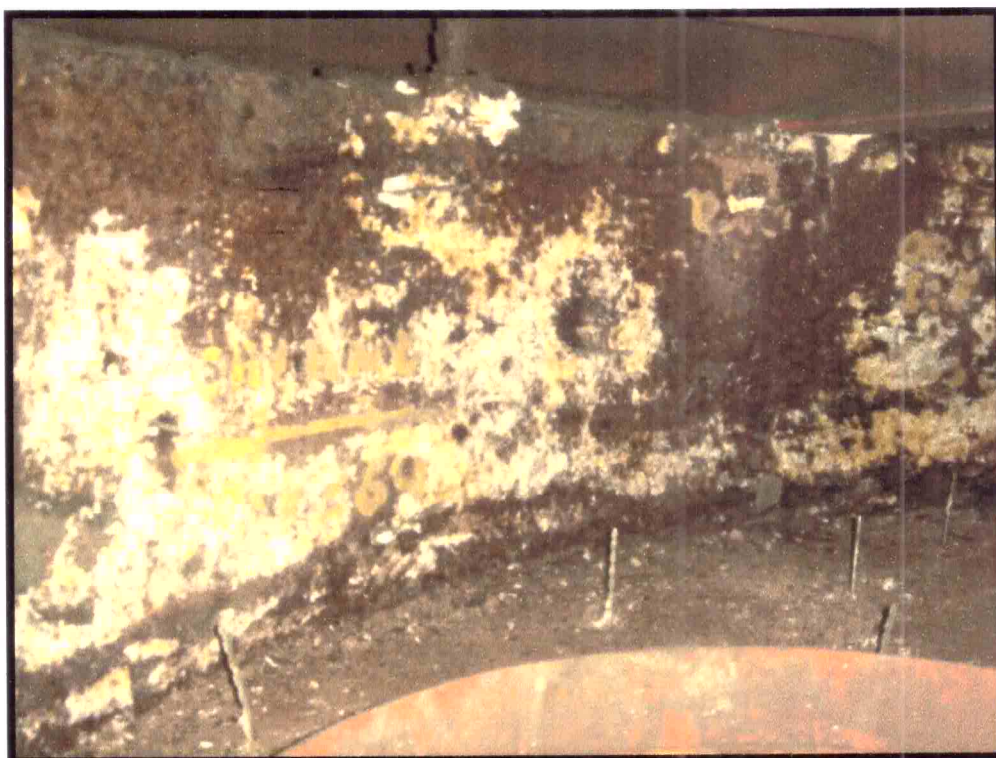
Remoção de manta do plenum
