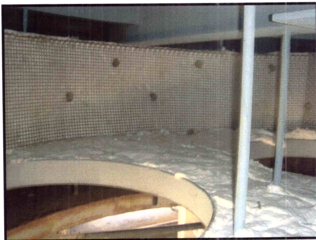
Montagem de manta cerâmica e tela no plennum
