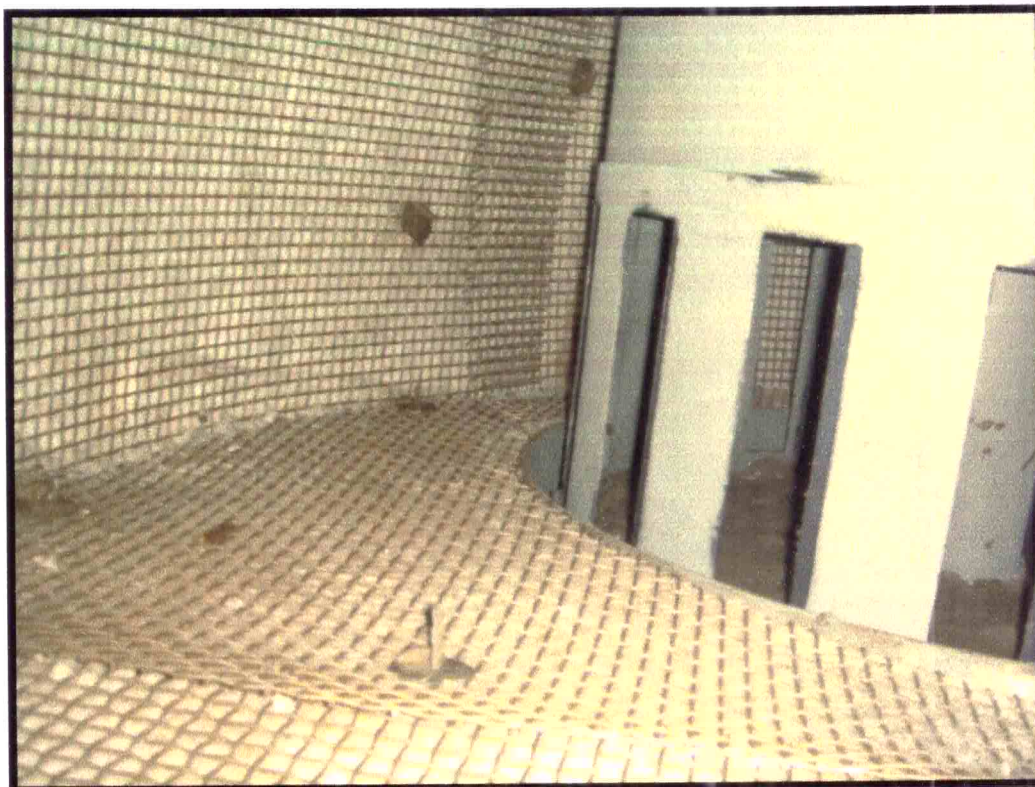
Montagem de manta cerâmica e tela no plennum
