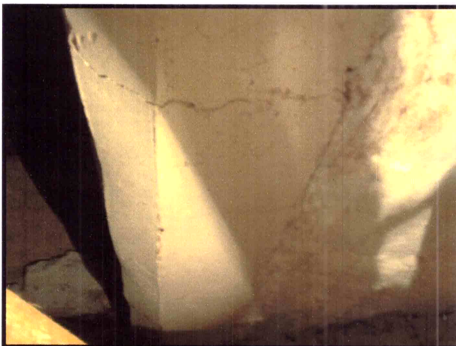
Trincas no concreto da transição
