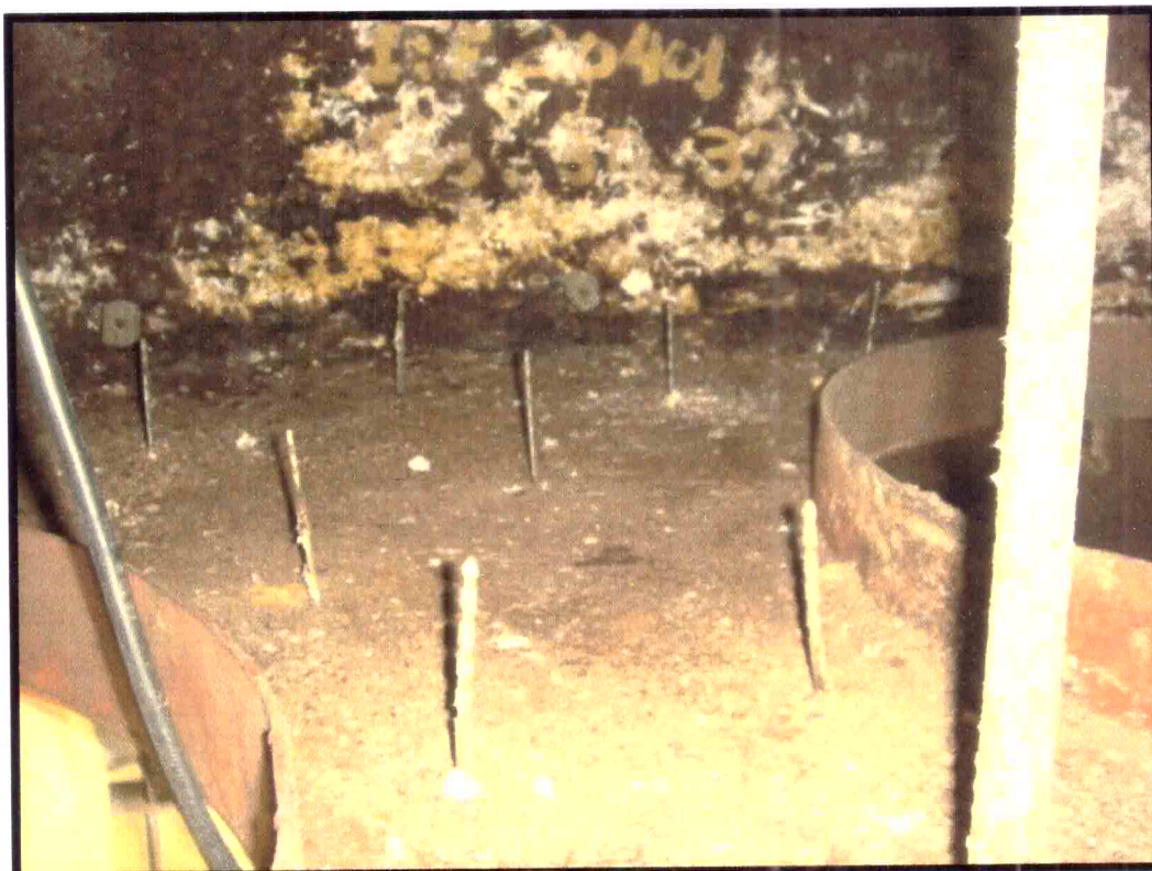
Retirada das mantas do plenum
