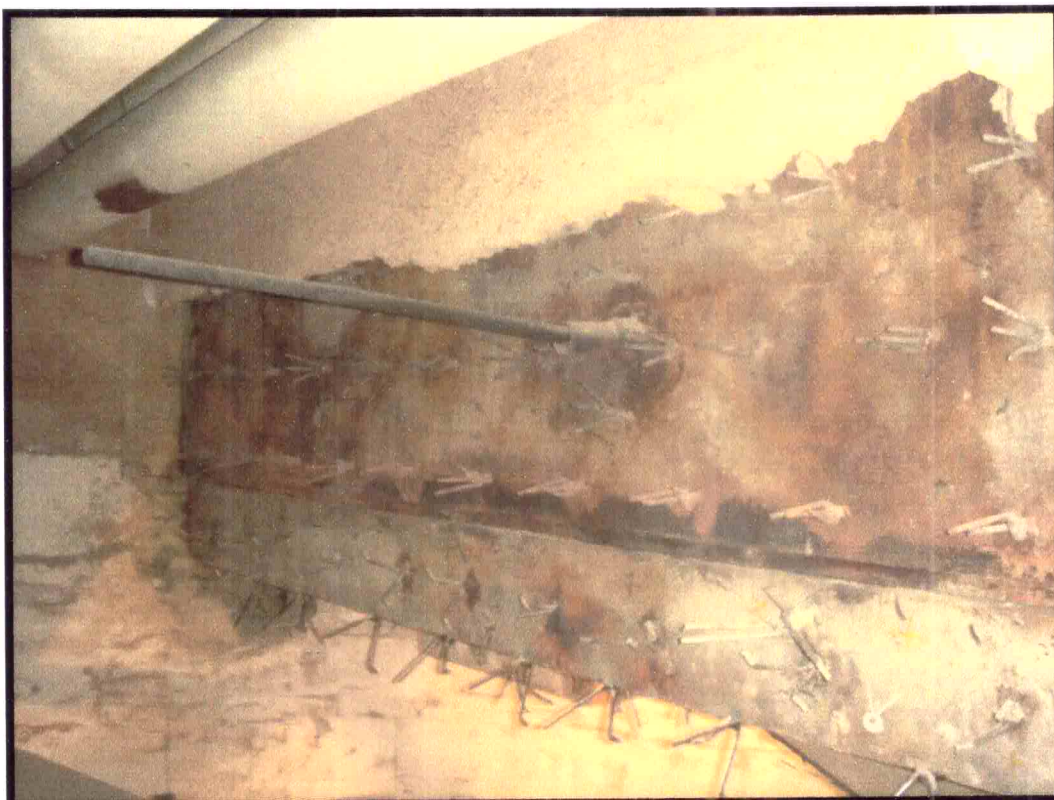
Demolição do Concreto da transição
