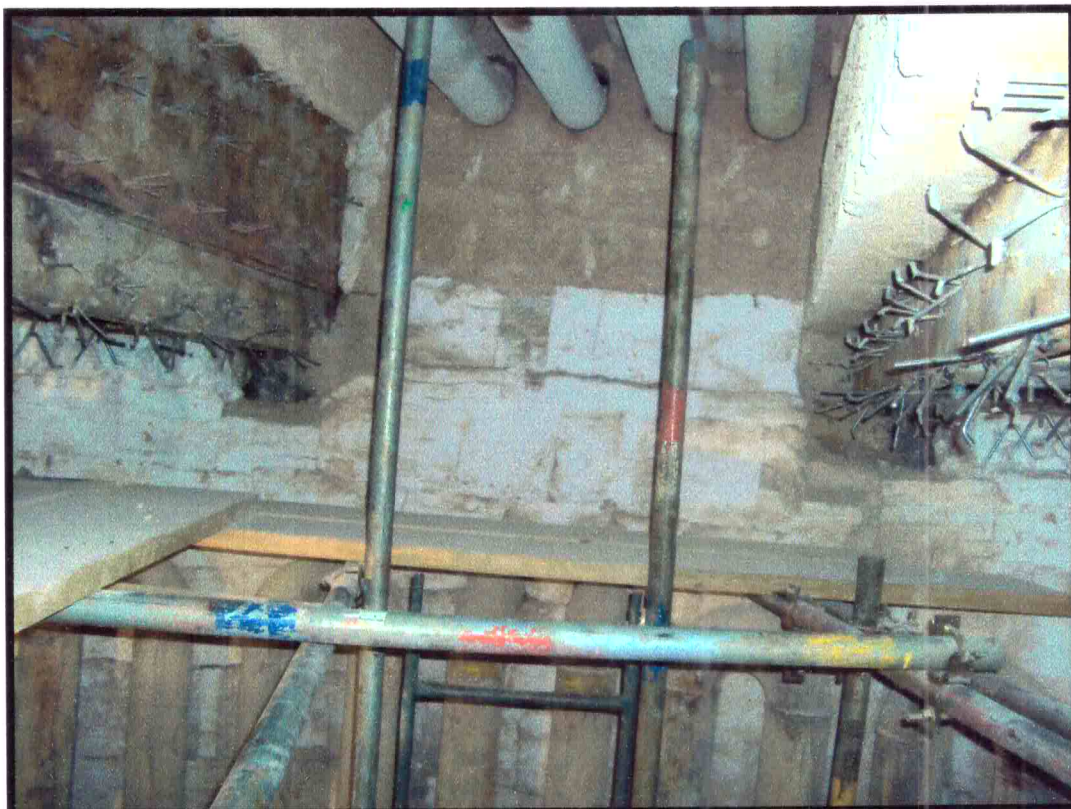
Montagem de módulos cerâmicos no costado
