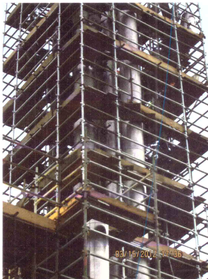
Foto 18 – Injeção de poliuretano expandido e acabamento com chapas de proteção de alumínio liso de 1,0 mm na T-102/101.
