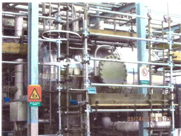
Foto 13 – Aplicacao de Lamel Max com espessura de 51 mm no V-108.
