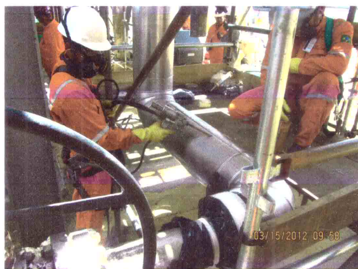
Foto 19 – Injeção de poliuretano expandido e acabamento com chapas de proteção de alumínio liso de 0,8 mm em linhas da UPGN.
