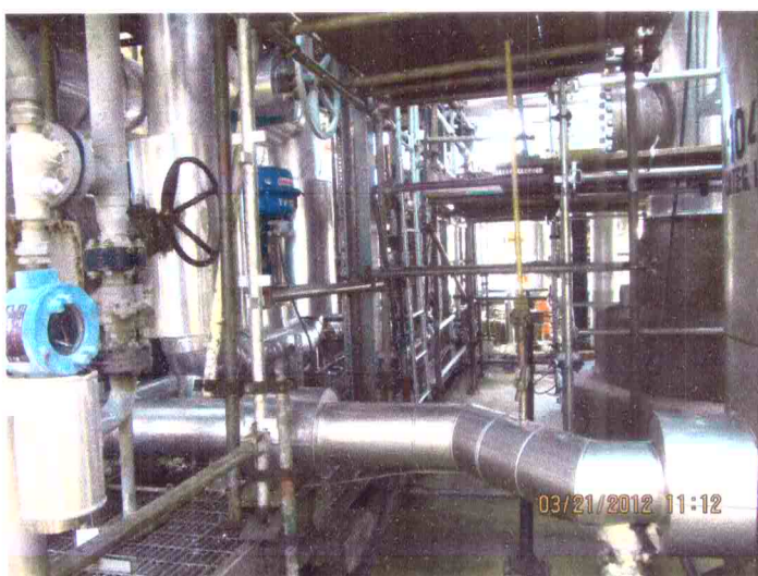
Foto 21 – Acabamento final em chapas de alumínio liso de 0,8mm nas linhas, válvulas e flanges da UPGN.
