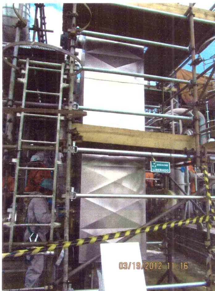
Foto 15 – Injeção de poliuretano expandido e acabamento com chapas de proteção de alumínio liso de 1,0 mm no E-101 A.
