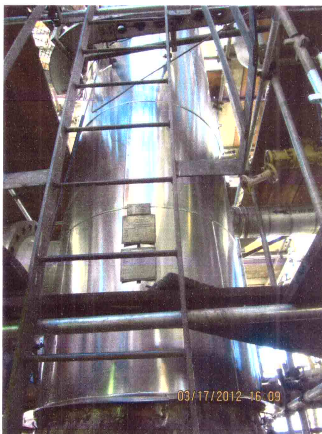
Foto 14 – Aplicacao de Lamel Max com espessura de 51mm e acabamento em chapa de proteção de 1,0 mm no T-102.
