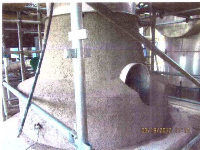
Foto 09 – Desforma e conclusão do Fire Proofing.
