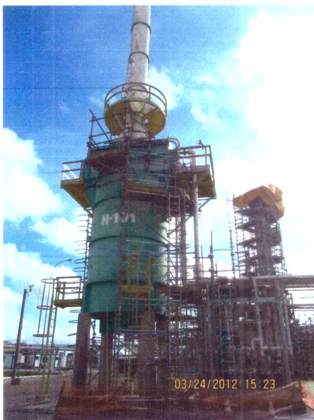
Foto 06 – Foto externa do forno H-101
