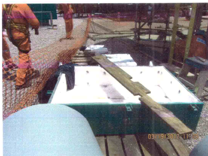
Foto 04 – Aplicacao de manta de fibra cerâmica na tampa da caixa de curva da convecção e argamassa moldável na proteção das ancoragens.
