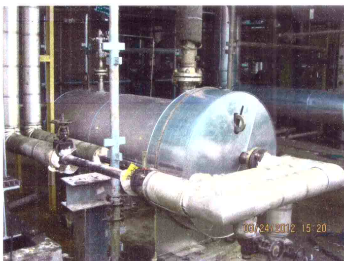
Foto 17 – Injeção de poliuretano expandido e acabamento com chapas de proteção de alumínio liso de 1,0 mm no V-110.
