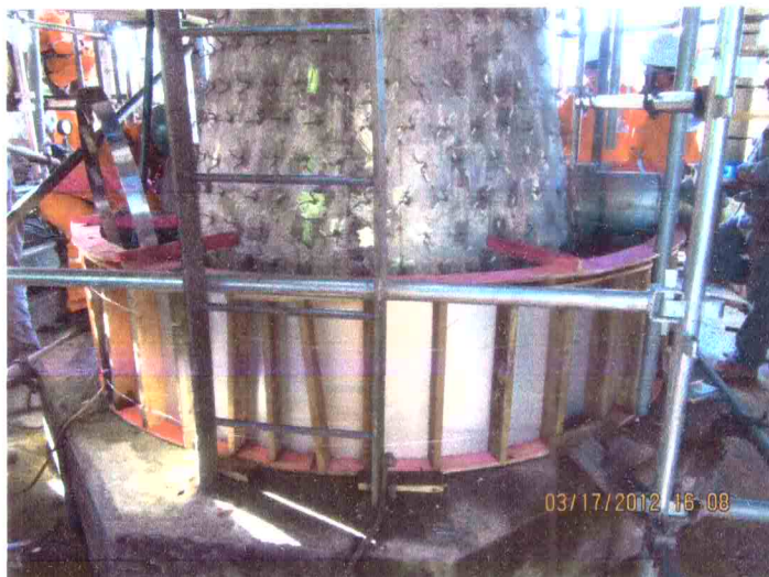
Foto 07 – Confecção e montagem de forma.
