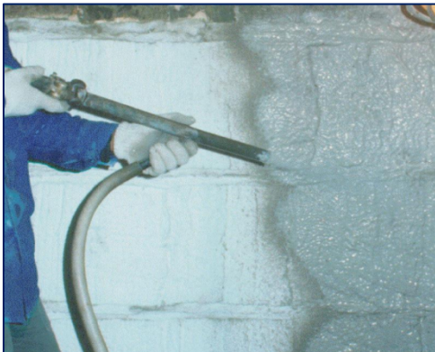
APLICAÇÃO DE COAT SOBRE OS MÓDULOS DE FIBRA CERÂMICA
