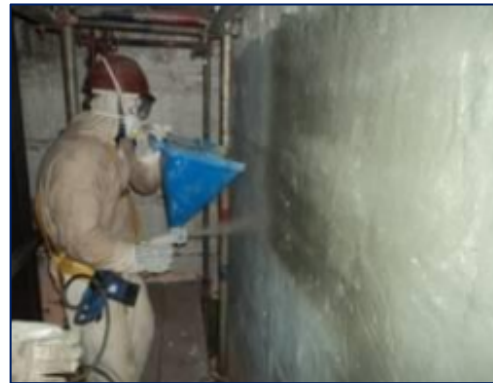
APLICAÇÃO DE COAT SOBRE OS MÓDULOS DE FIBRA CERÂMICA
