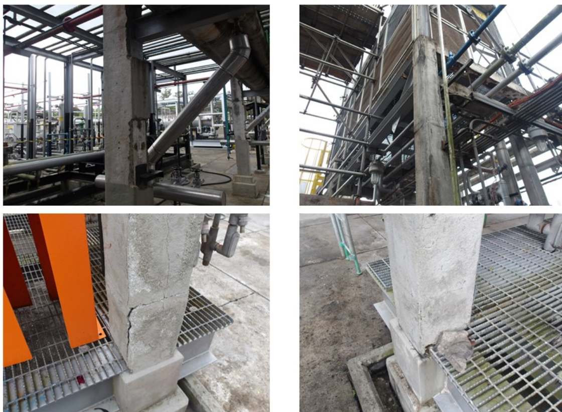
Imagem 2 - Situação de trincas com dimensão acima de 1 mm e desprendimento do revestimento Fireproofing.
