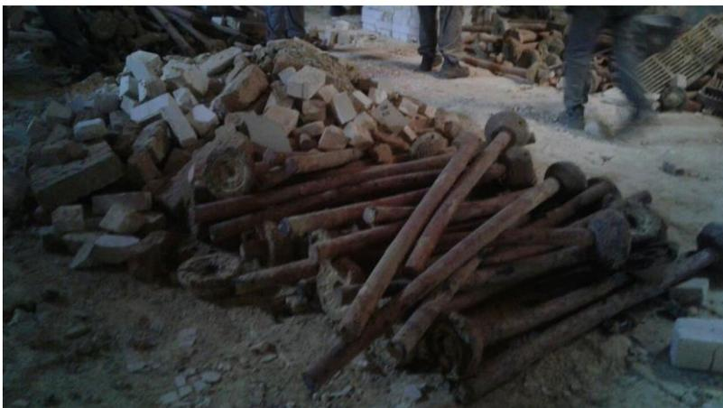
**FOTO 05:** Remoção dos pilares e demolição dos refratários.
