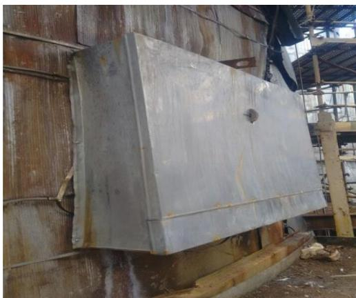
**Foto 02** – Instalação das chapas nas BV's.
