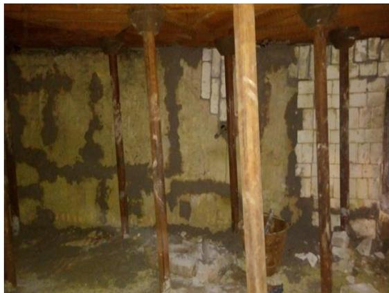
**Foto 07** – Reparo nas trincas conforme orientação da fiscalização e assentamento dos tijolos das BV's.
