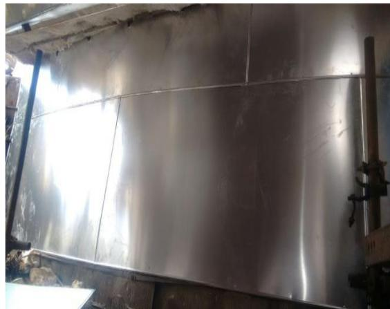
**Foto 04** – Montagem da chapa de proteção do Isolamento.
