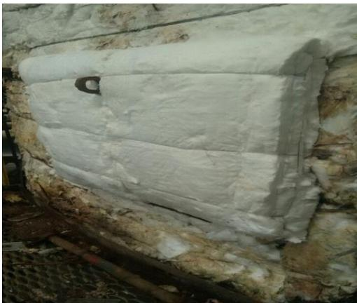
**Foto 01** – Recomposição dos isolamentos térmicos das BV's.
