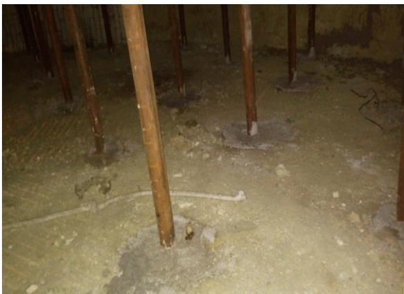
**Foto 06** – Concretagem da base dos pilares das Grelhas.
