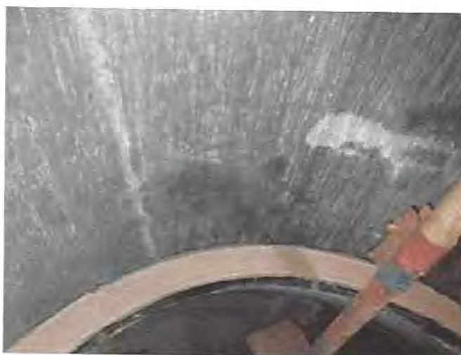
Figura 13 – Nivelamento da base do carretel inferior.
