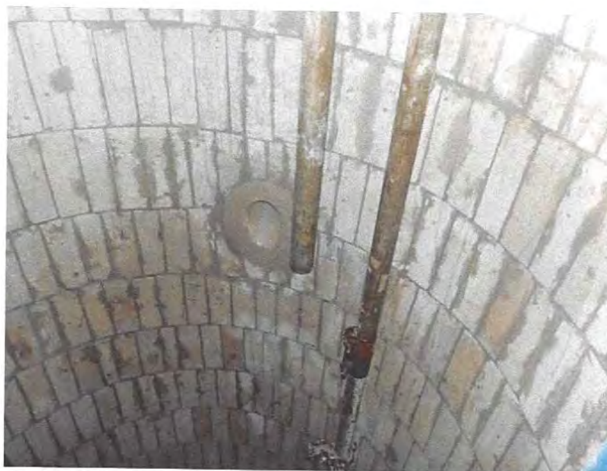
Figura 27 – Revestimento antiácido com detalhe para o ajuste interno do insert.
