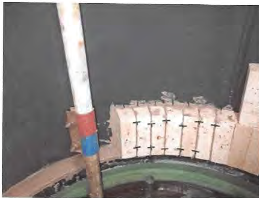
Figura 15 – Início da montagem da 1ª fiada.
