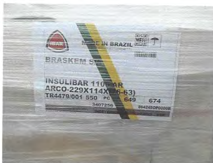
Figura 3 - Identificação dos materiais na frente de serviço: Insulibar AR Arco 2 229 x 114 x (76-63)
