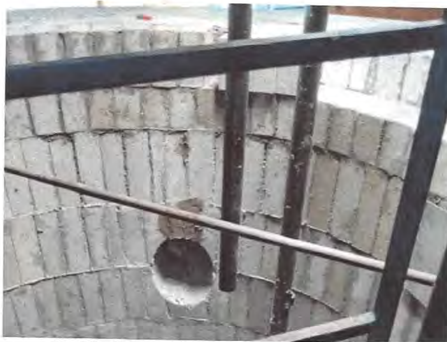
Figura 25 – Montagem dos tijolos antiácidos no carretel superior.
