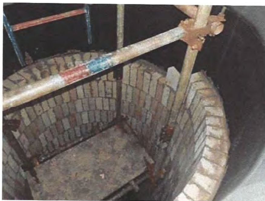
Figura 17 – Montagem do revestimento antiácido.
