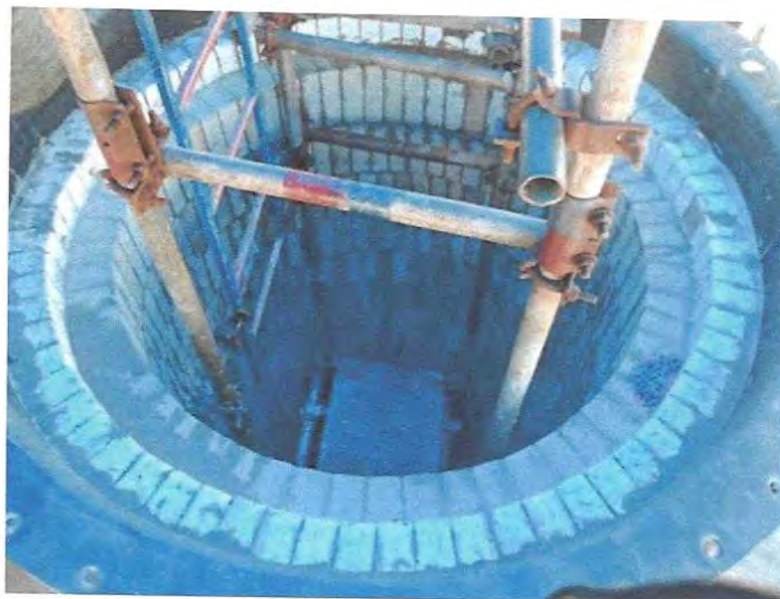
Figura 23 – Montagem dos tijolos isolantes.
