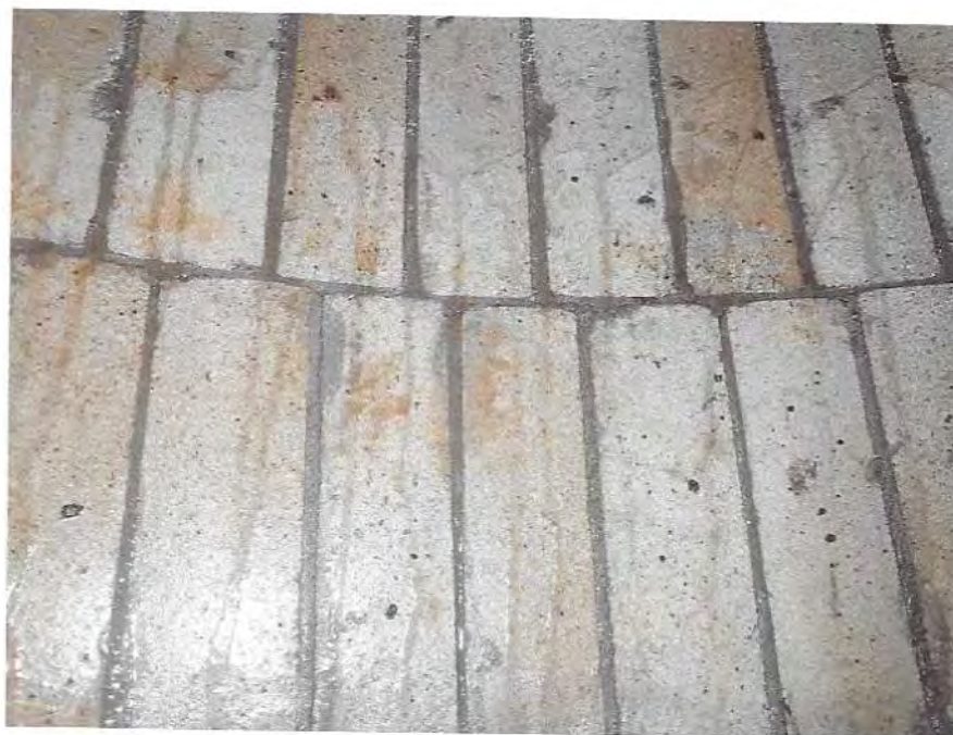
Figura 30 – Acidificação das juntas.
