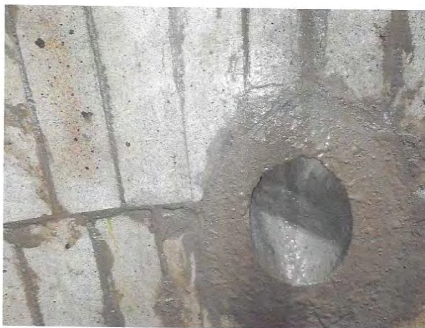
Figura 29 – Ajuste interno do insert.
