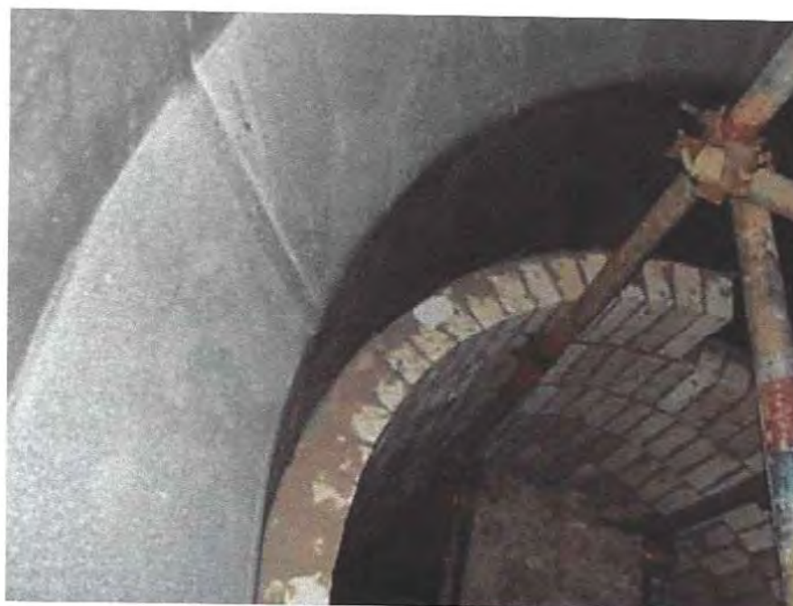
Figura 19 - Montagem do revestimento antiácido.
