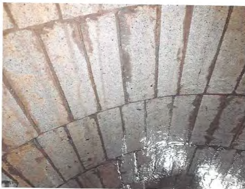
Figura 34 - Acidificação das juntas.
