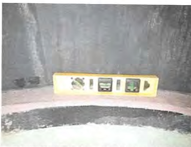
Figura 14 – Verificação do nivelamento da base com nível de bolha.
