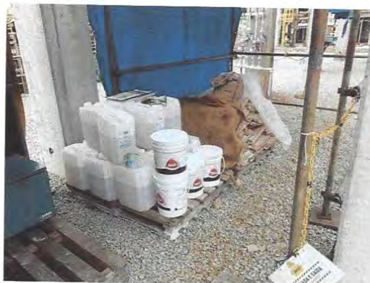
Figura 9 – Local de armazenamento dos materiais de aplicação.
