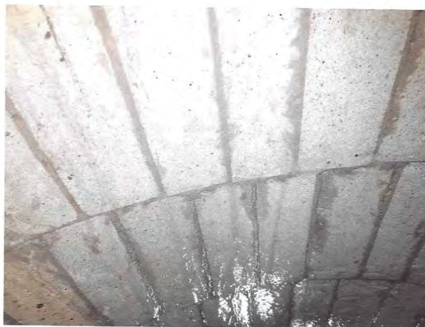
Figura 31 - Acidificação das juntas.
