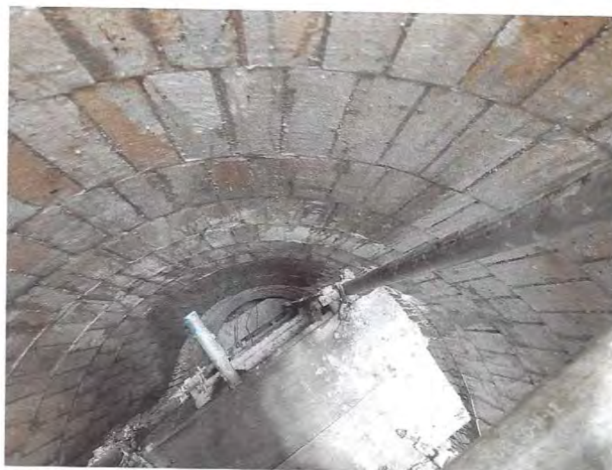
Figura 33 - Acidificação das juntas.
