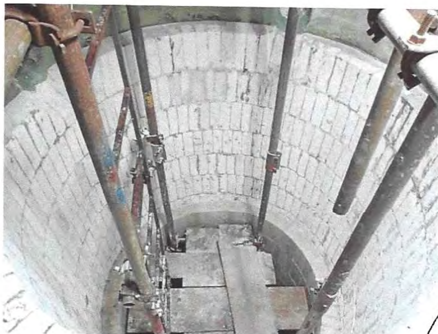
Figura 24 – Montagem dos tijolos isolantes.
