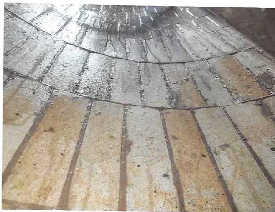
Figura 32 - Acidificação das juntas.
