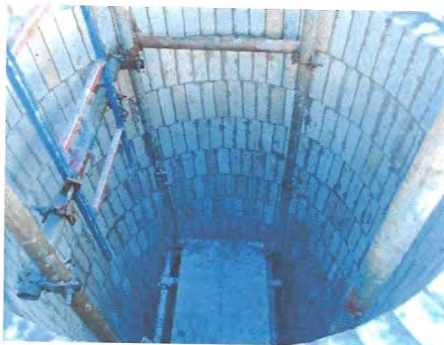
Figura 20 – Montagem do revestimento antiácido.
