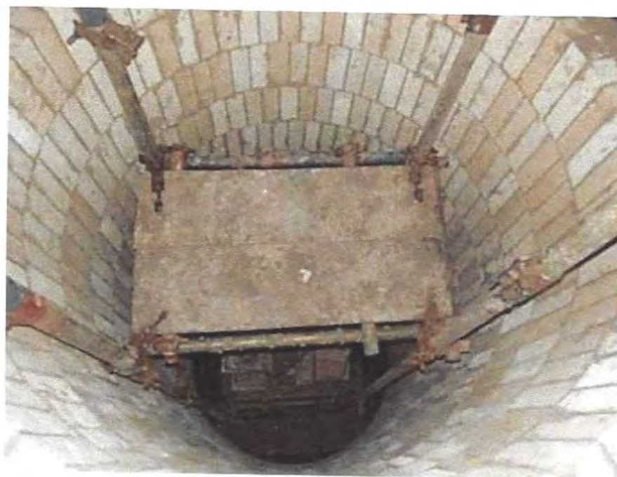
Figura 18 - Montagem do revestimento antiácido.
