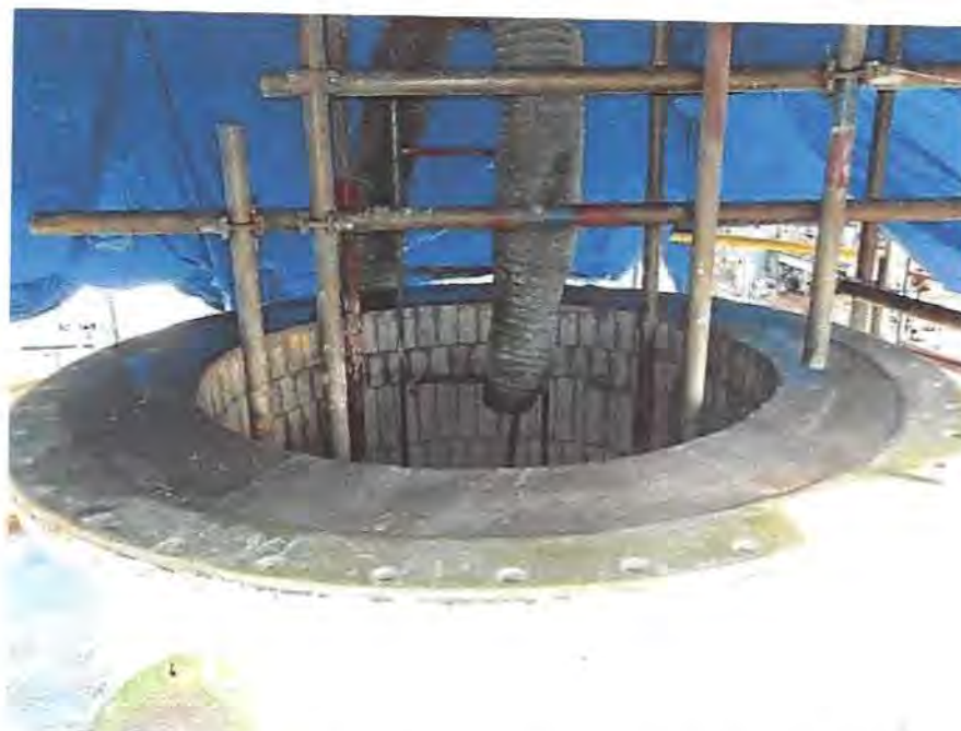
Figura 36 – Regularização superior e finalização da montagem.
