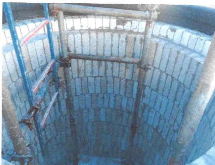
Figura 22 – Montagem dos tijolos isolantes.
