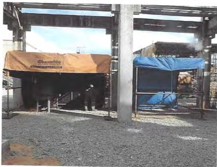
Figura 7 – Local de armazenamento dos materiais.
