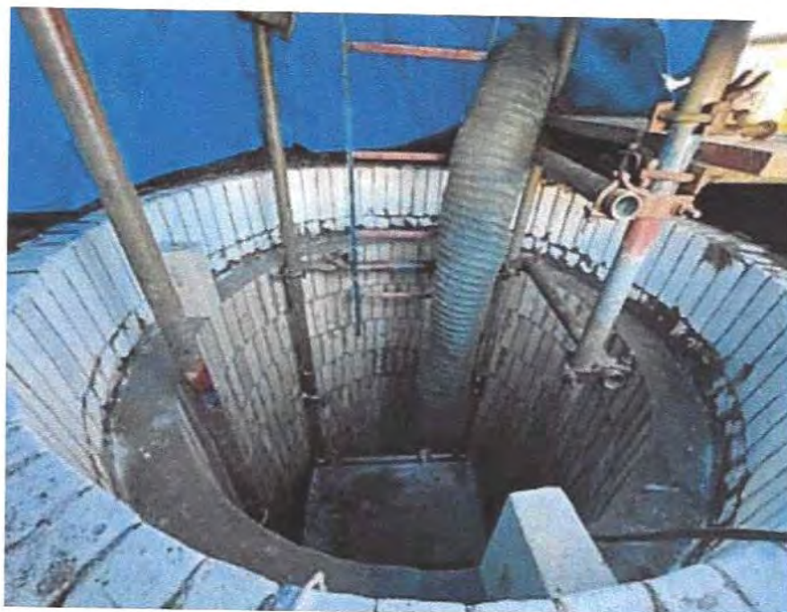
Figura 21 – Montagem dos tijolos isolantes.
