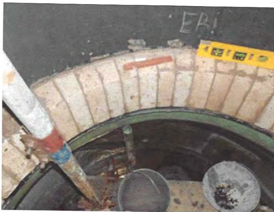
Figura 16 – Conclusão da montagem da 1ª fiada.
