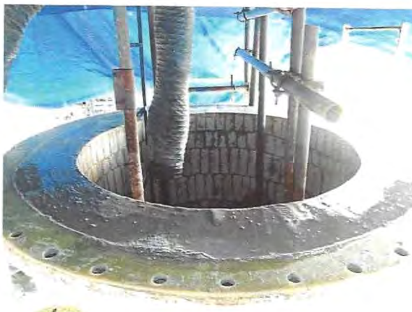
Figura 35 – Regularização superior após a instalação da última fiada das camadas isolantes e antiácida.
