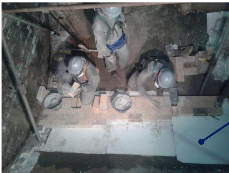
FOTO 07 – Aplicação da placa de fibra cerâmica PYROSTOP BOARD 1260 no cilindro.
