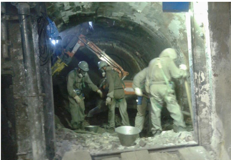
Foto 01 – Demolição com auxílio do Robô Brock.
