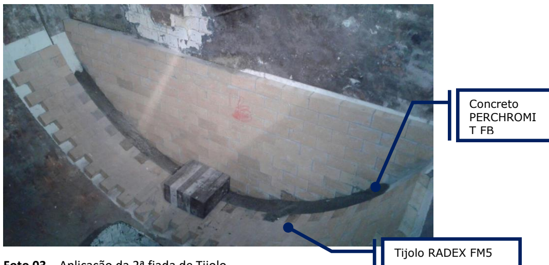
Foto 03 – Aplicação da 2ª fiada de Tijolo.
