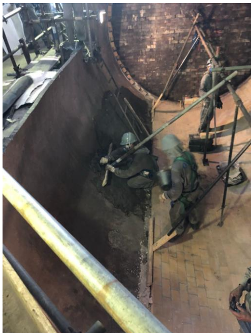
FOTO 06 – Aplicação do concreto PERCHROMIT FB para nivelamento da carcaça do cilindro.
