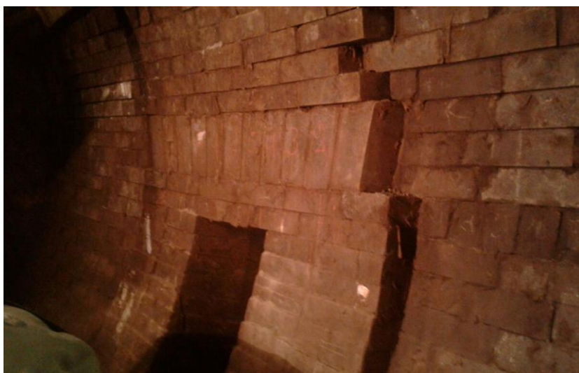
FOTO 14 – Montagem dos tijolos no lado das ventaneiras.
