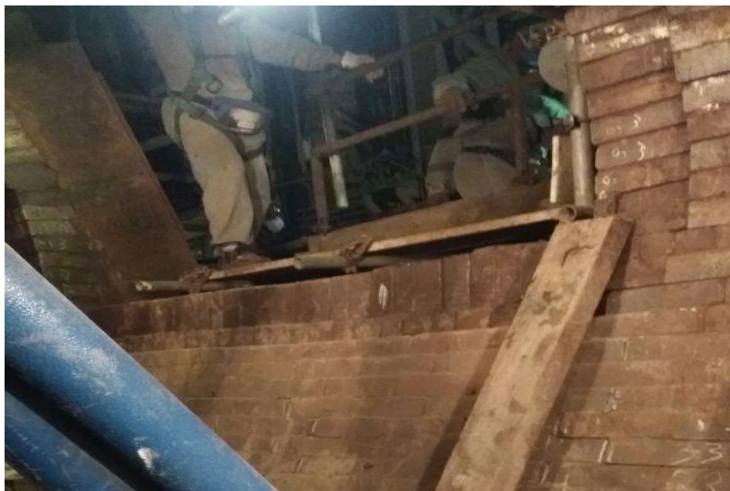
FOTO 15 – Montagem dos tijolos da boca de carga na parte inferior.
