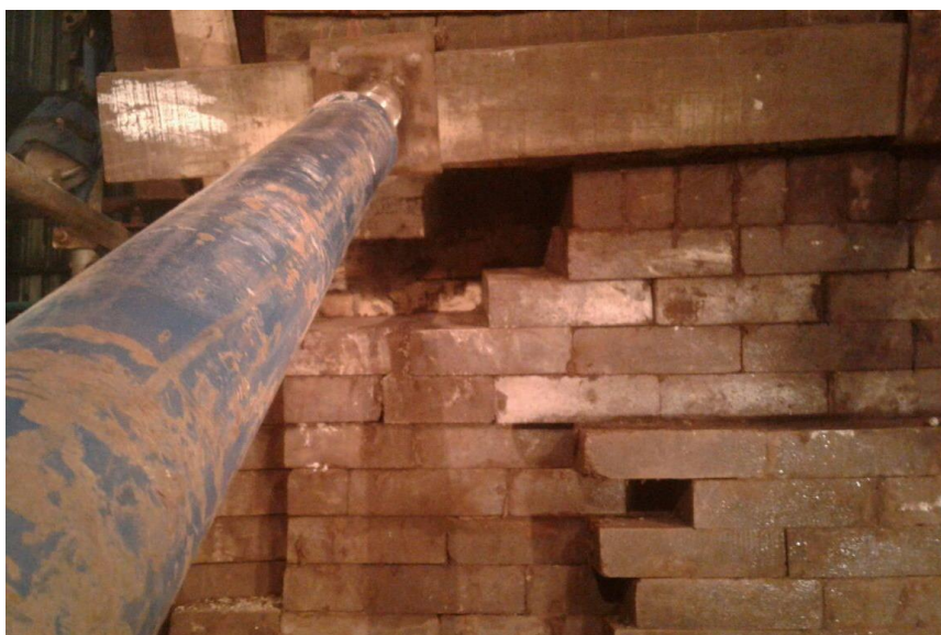
FOTO 16 – Fechamento geral do cilindro na região das ventaneiras.
