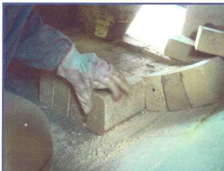
Foto 04 - Assentamento do tijolo refratário
