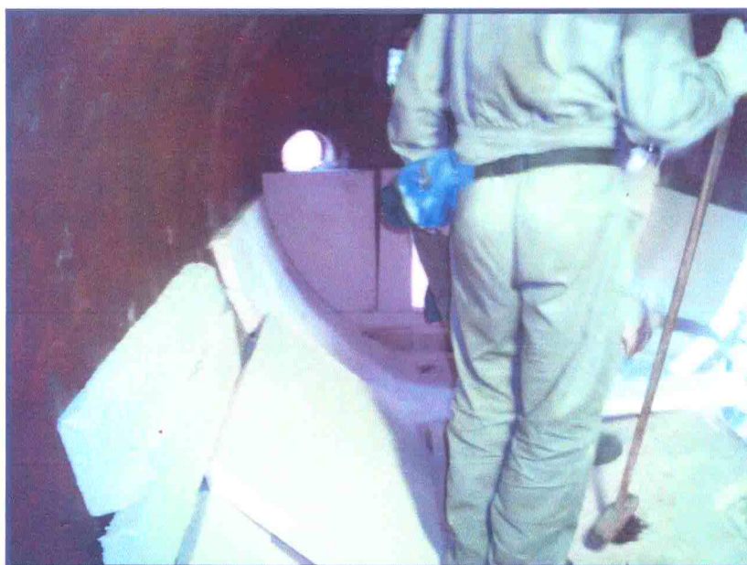
Foto 02 - Aplicação da Fibra Cerâmica ( Duraboard RK )
