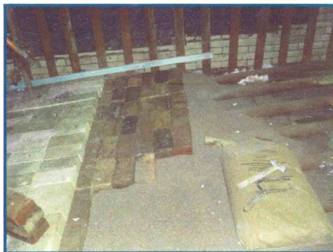
FOTO 04 – APLICAÇÃO DO AGREGADO CINASITA E MONTAGEM DAS DUAS CAMADAS DE TIJOLO REFRATARIO.
