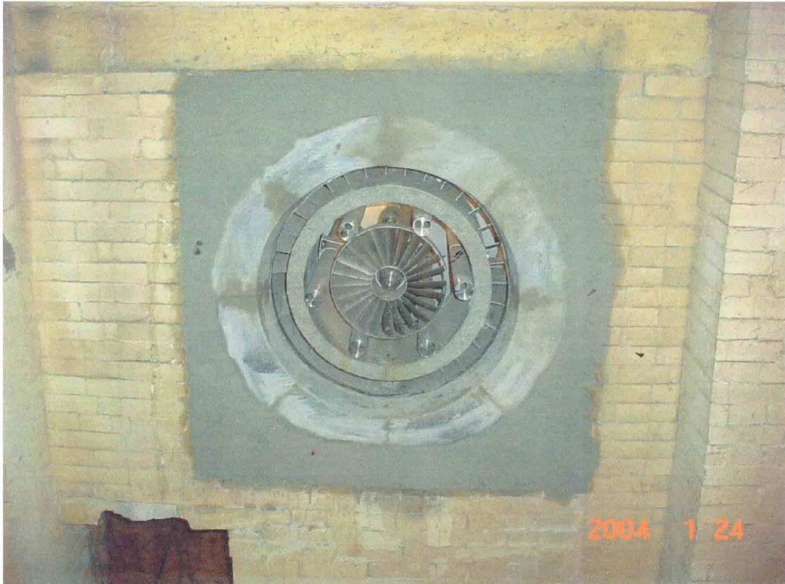
Conclusão da montagem do bloco queimador na caldeira (B-6320).
