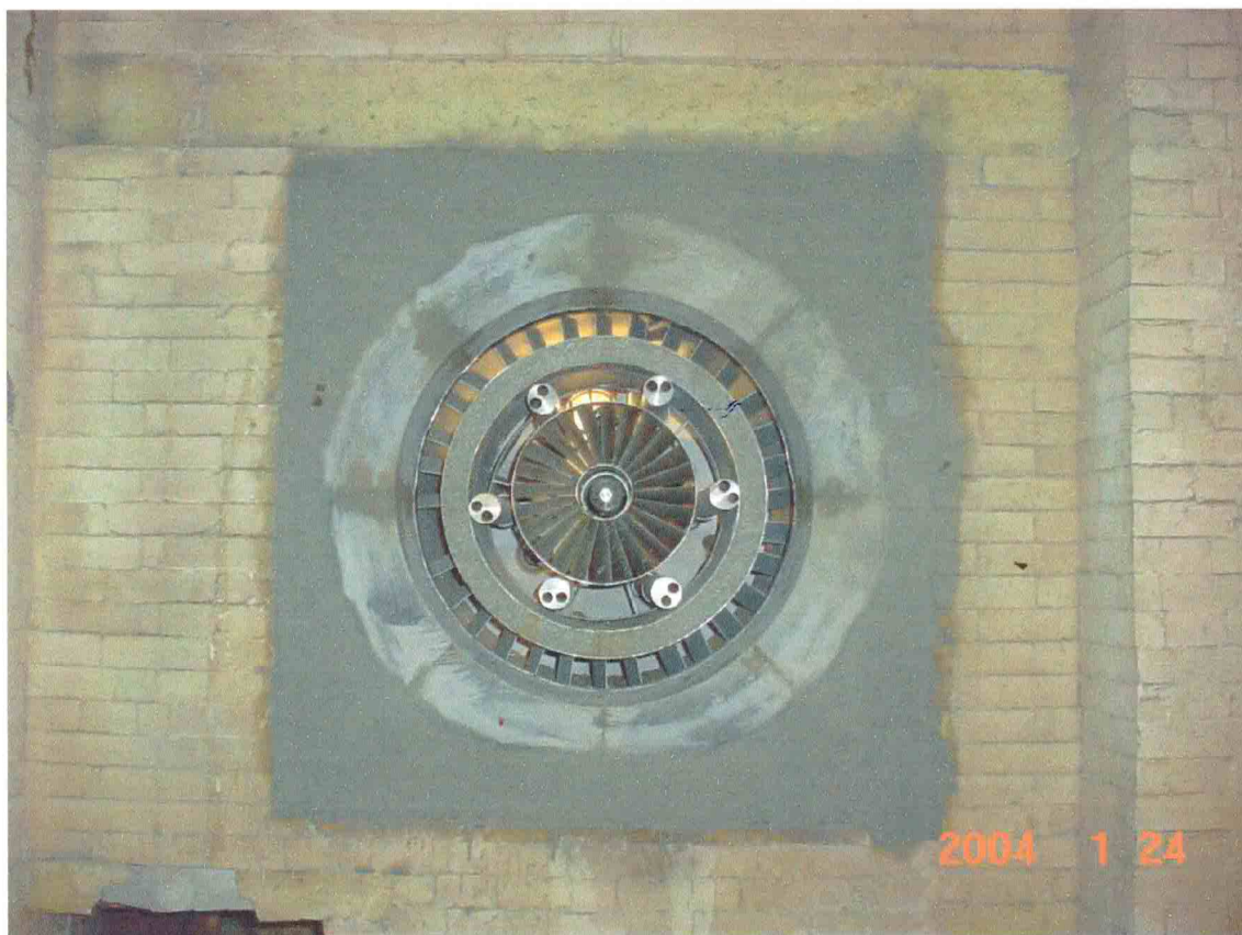
Conclusão da montagem do bloco queimador na caldeira (B-6310).
