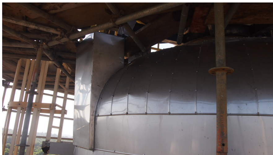
Figura 13 - Montagem do revestimento metálico fixado com parafuso inox e arruela de Neoprene no olhal e boleado.
