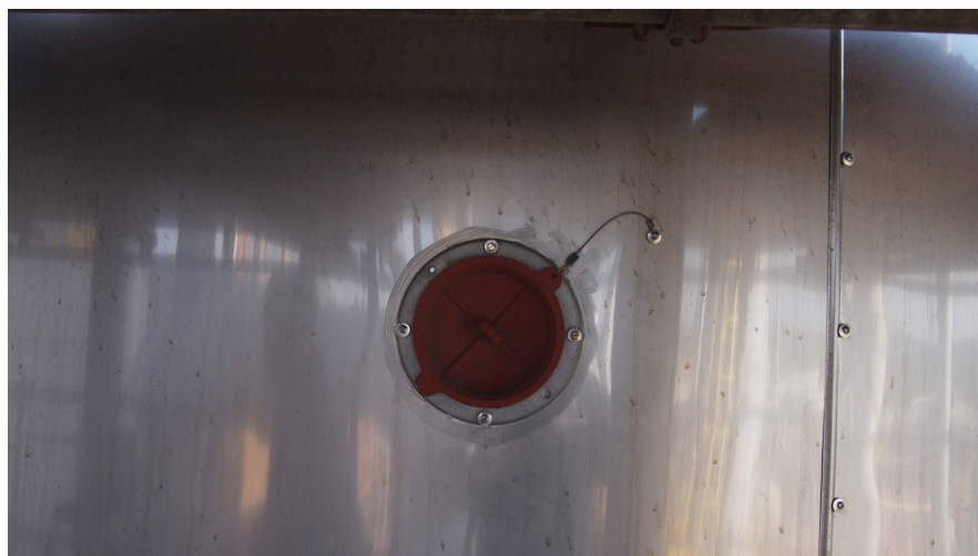
Figura 12 - Instalação de janelas de inspeção, conforme padrão DOW G15S-1032-00.
