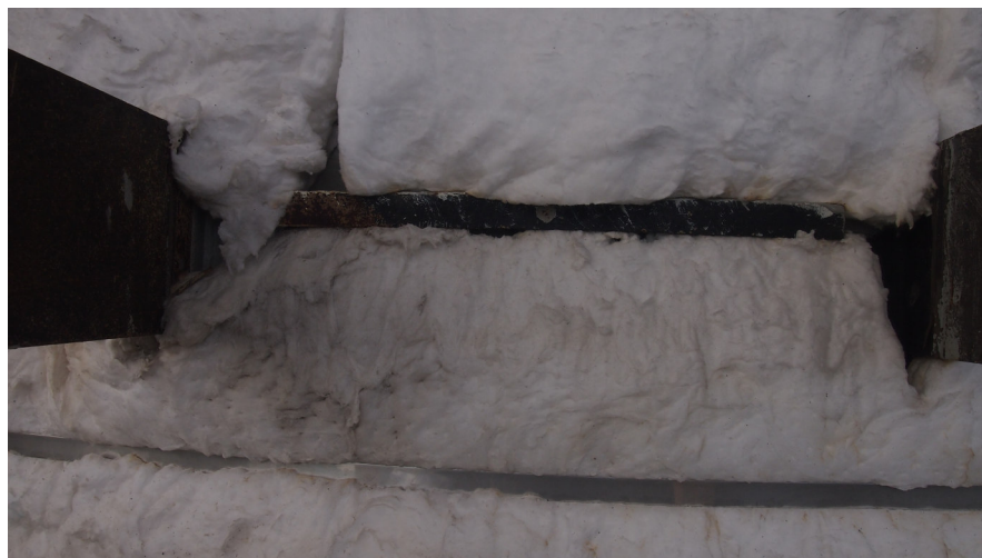
Figura 3 - Instalação de barra chata e início da aplicação do isolamento térmico.
