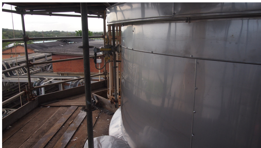
Figura 9 - Montagem do revestimento metálico fixado com parafuso inox e arruela de Neoprene.
