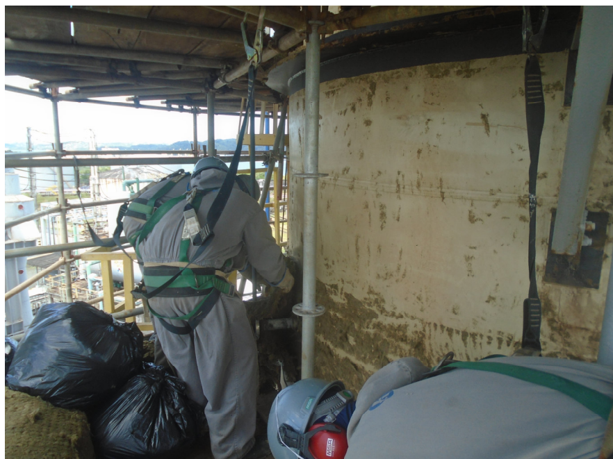
Figura 1 – Remoção do isolamento térmico antigo.
