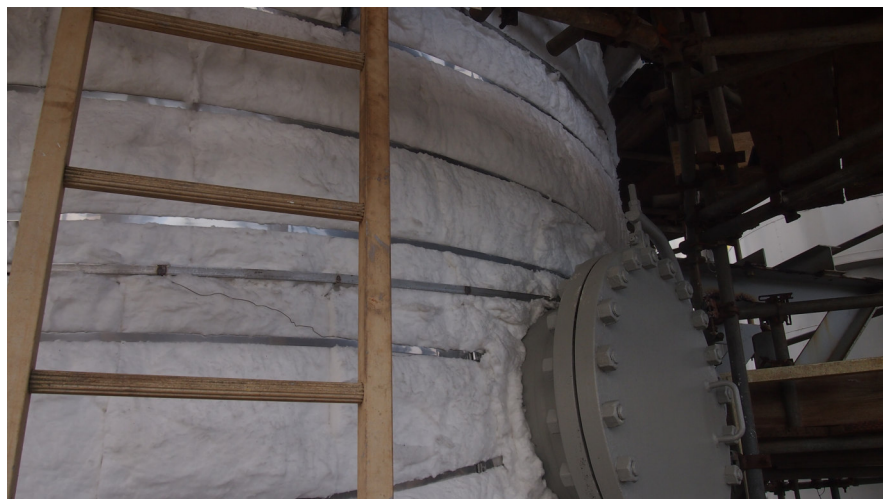
Figura 5 - Aplicação do isolamento térmico.
