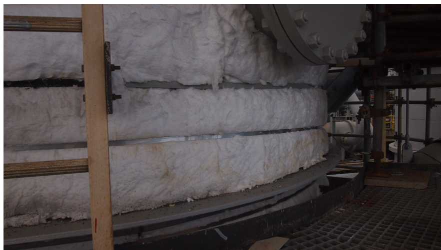
Figura 6 - Aplicação do isolamento térmico.
