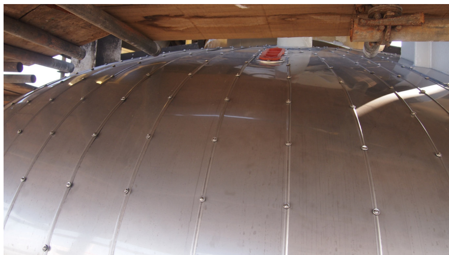
Figura 14 - Montagem do revestimento metálico fixado com parafuso inox e arruela de Neoprene no olhal e boleado.
