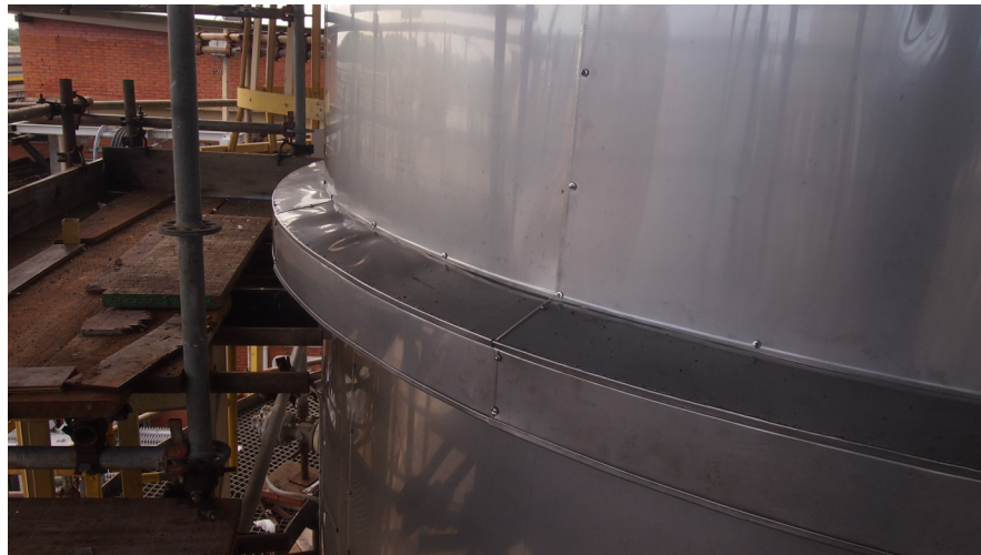
Figura 8 - Fabricação e montagem do revestimento metálico.
