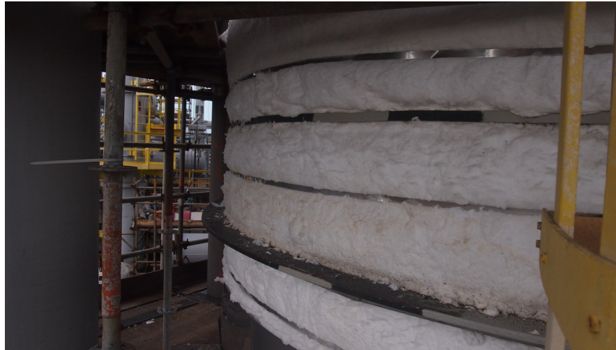
Figura 4 - Instalação de barra chata e início da aplicação do isolamento térmico.
