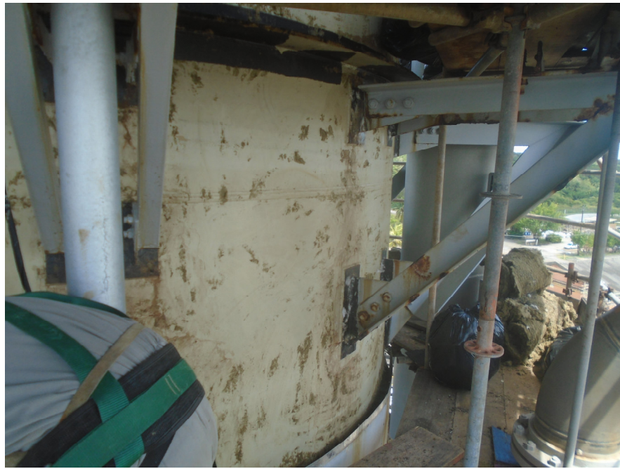
Figura 2 - Remoção do isolamento térmico antigo.
