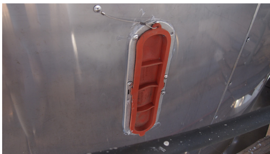
Figura 11 - Instalação de janelas de inspeção, conforme padrão DOW G15S-1032-00.
