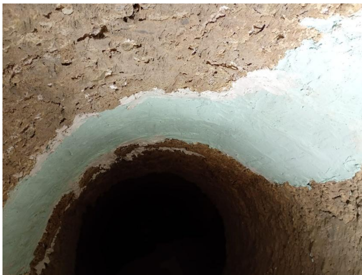
Foto 4: utilização de massa silplate na zona de transição.
