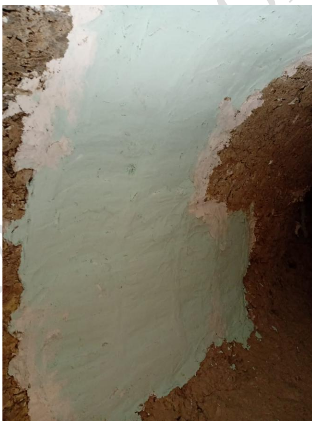
Foto 5: utilização de massa silplate na zona de transição.
