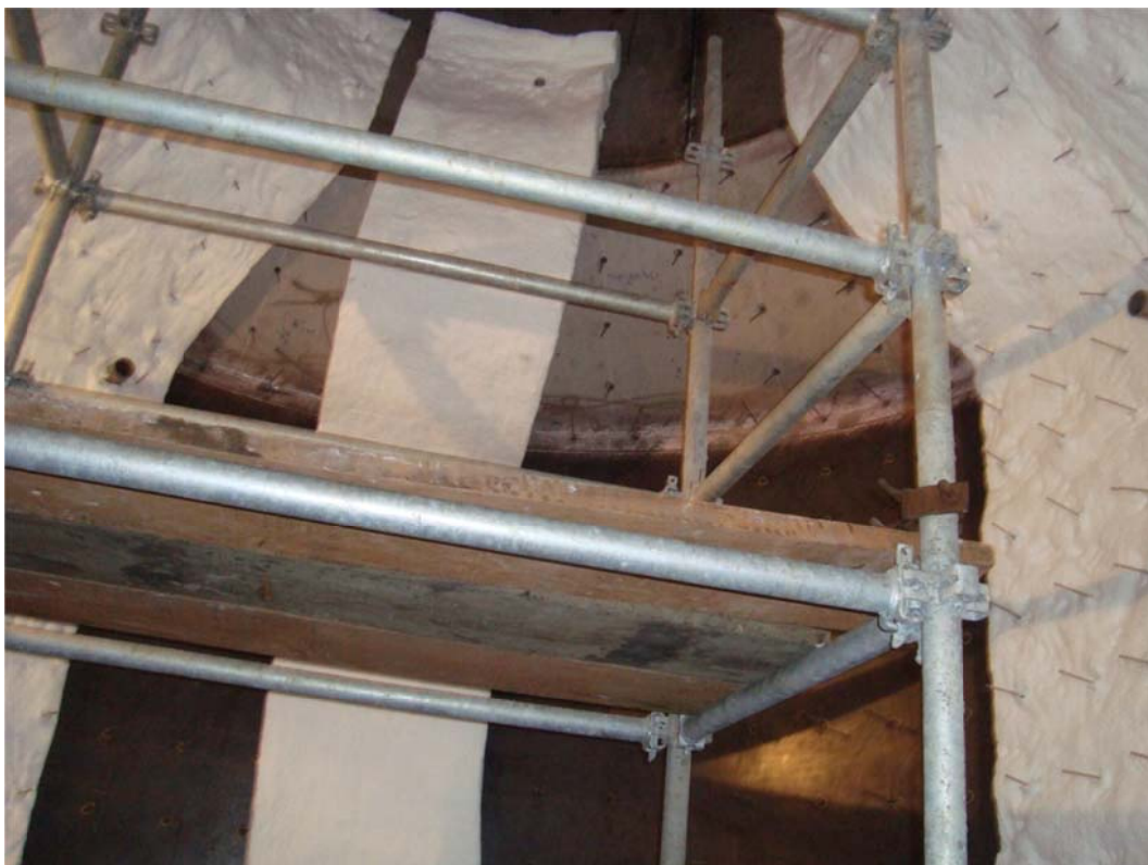
FOTO 11: Aplicação da primeira camada de fibra cerâmica Durablanket.
