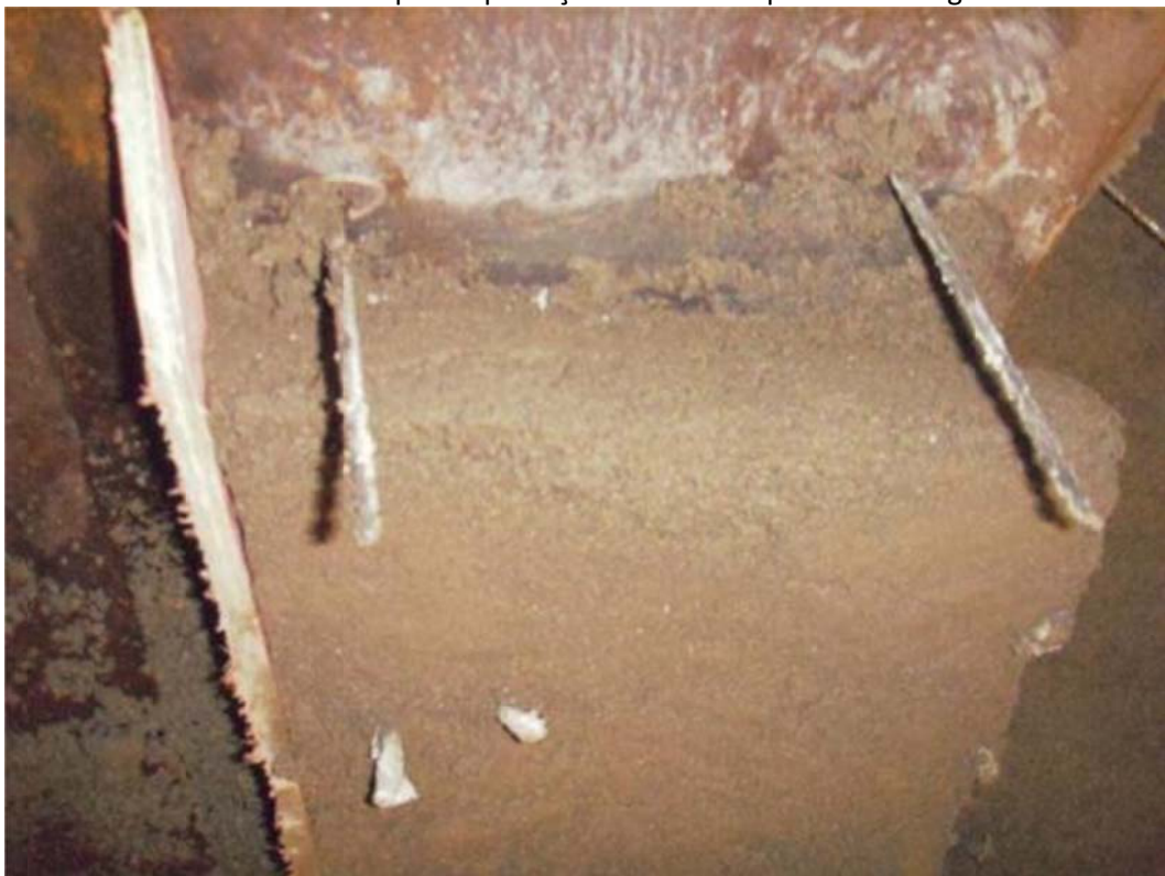
FOTO 02: Aplicação da primeira etapa do concreto Legrit 15 CD.
