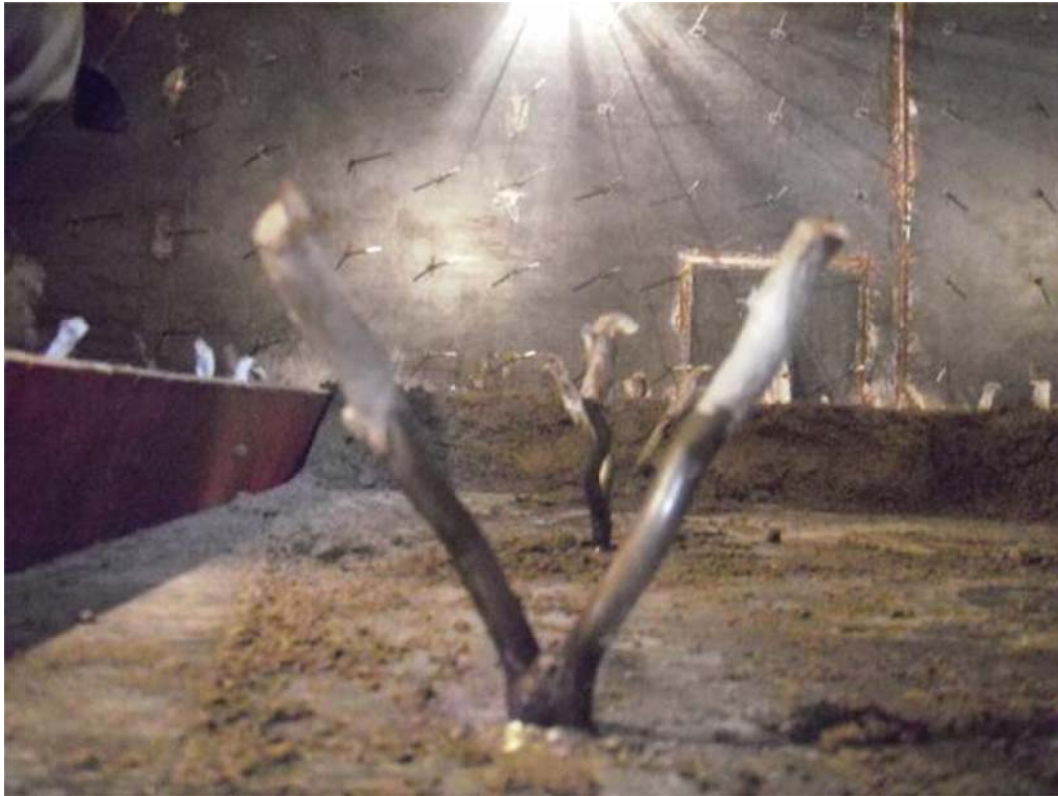
FOTO 01: Detalhe para a proteção com fita crepe nas ancoragens.
