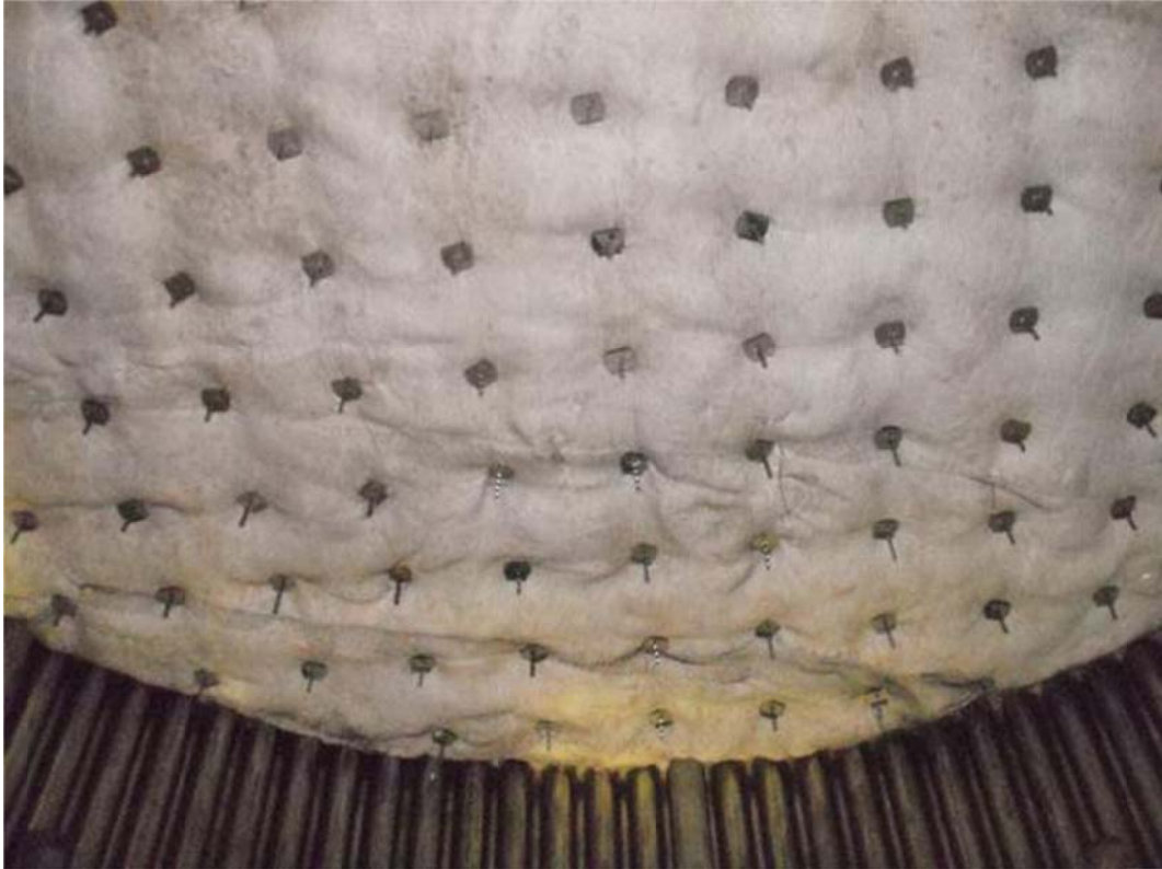
FOTO 18: Aplicação de fibra cerâmica Durablanket no teto do salão inferior do P-1110.
