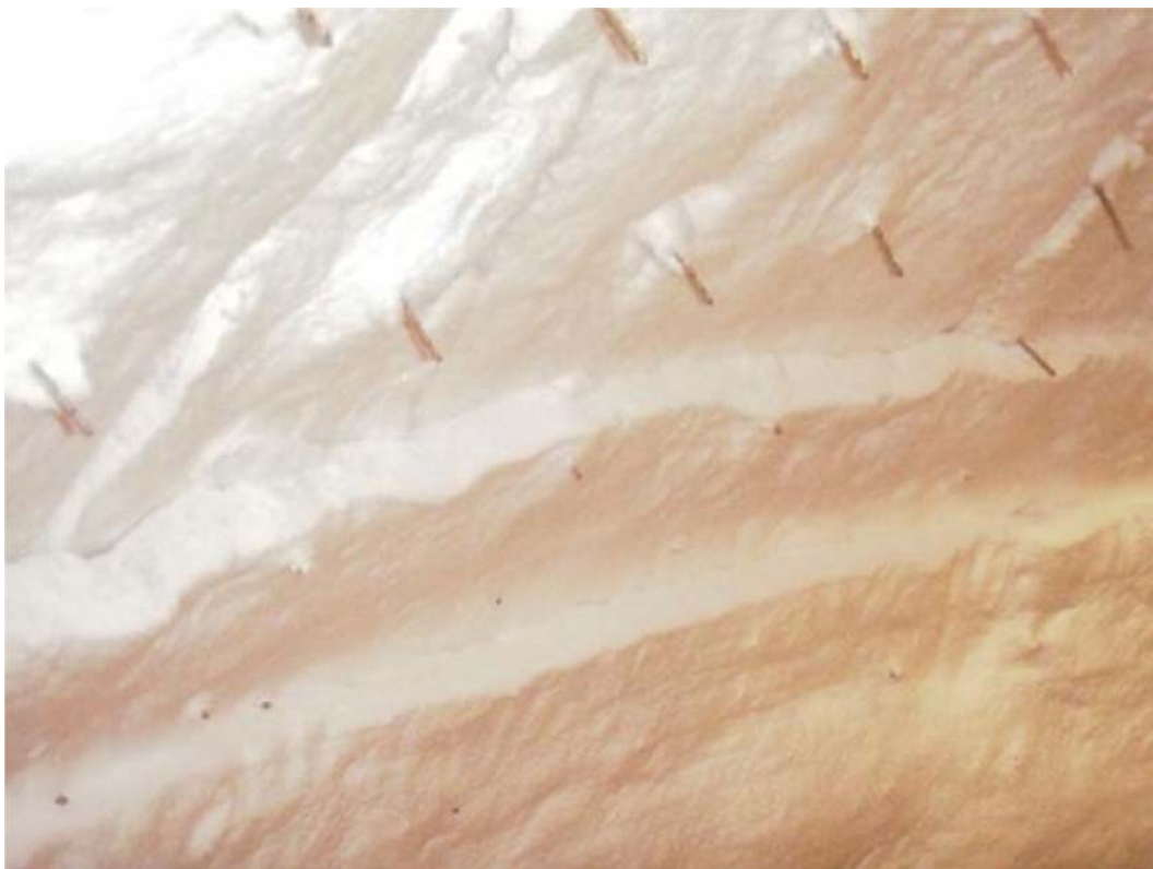
FOTO 15: Detalhe da região onde contempla três camadas de fibra cerâmica Durablanket.
