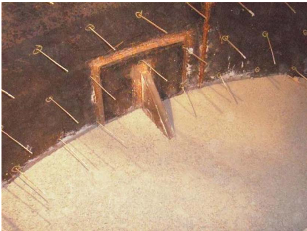
FOTO 07: Conclusão da segunda etapa do concreto Comprit 60 CD.
