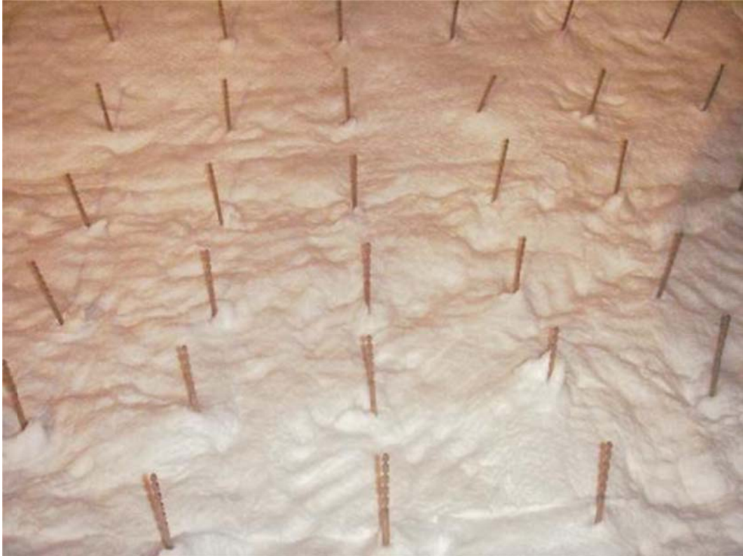
FOTO 13: Aplicação da primeira camada de fibra cerâmica Durablanket.
