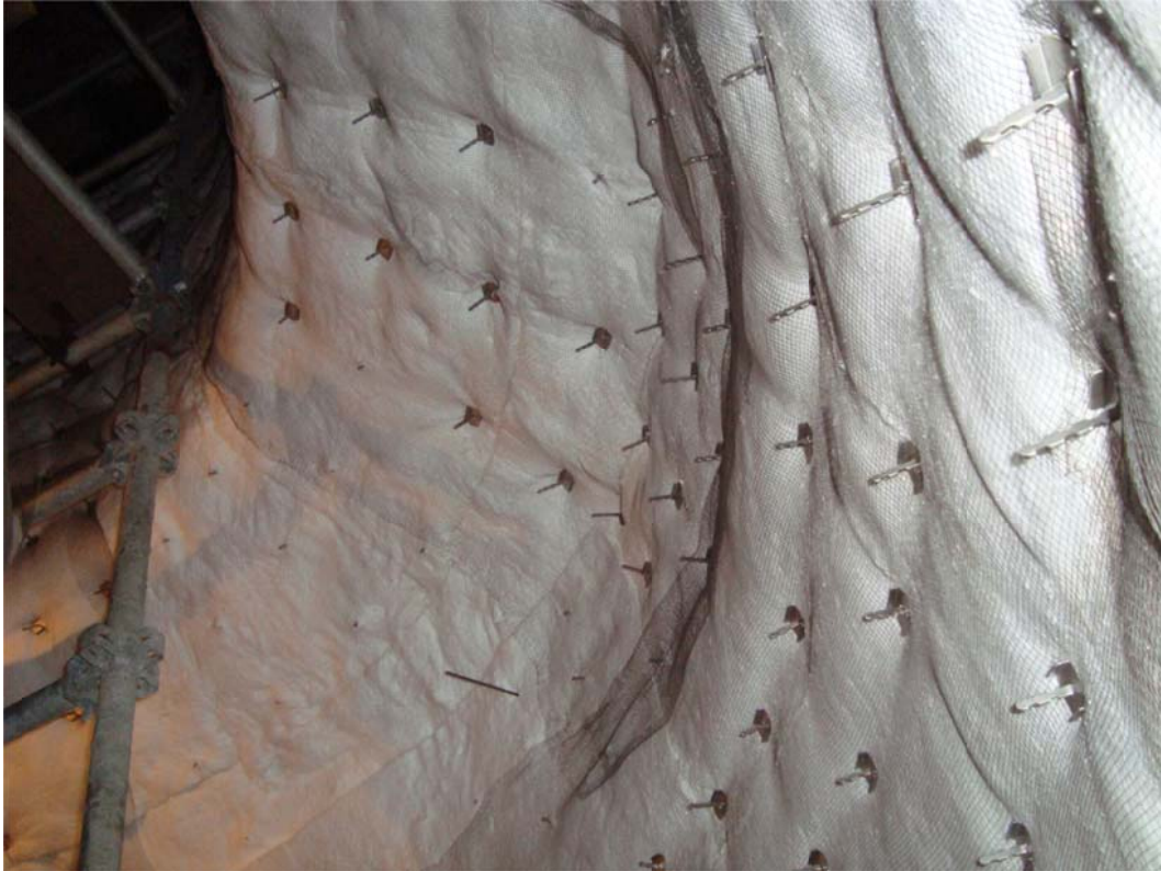
FOTO 16: Instalação da tela Inconel 601.
