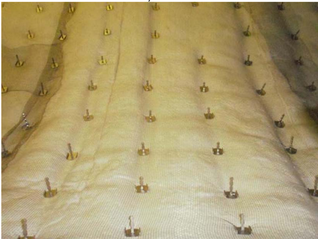
FOTO 17: Detalhe dos pinos e arruelas em inox 304 da fixação da tela Inconel 601.
