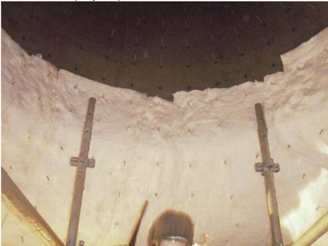
FOTO 14: Aplicação da segunda camada de fibra cerâmica Durablanket.
