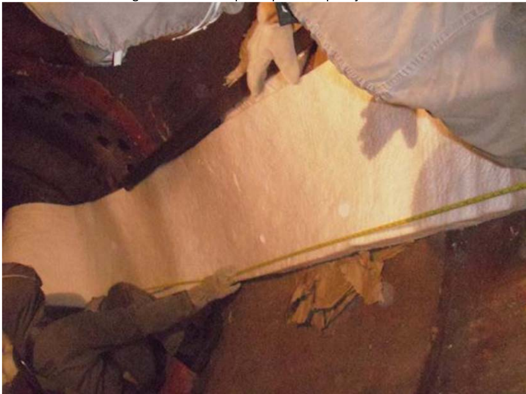
FOTO 10: Pré-montagem da manta cerâmica Durablanket.
