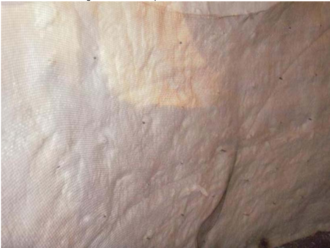
FOTO 16: Começo da instalação da tela Inconel 601.
