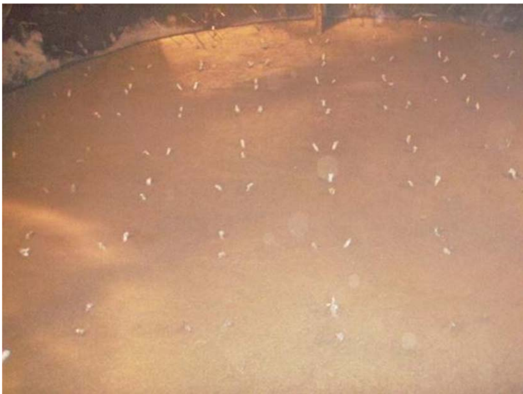
FOTO 03: Conclusão da primeira etapa do concreto Legrit 15 CD.
