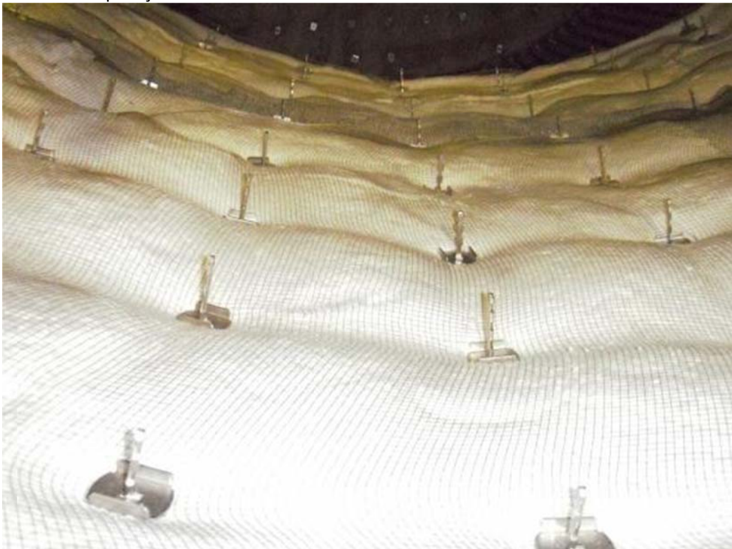
FOTO 19: Costado do P-1110 com a aplicação de manta cerâmica Durablanket concluída.
