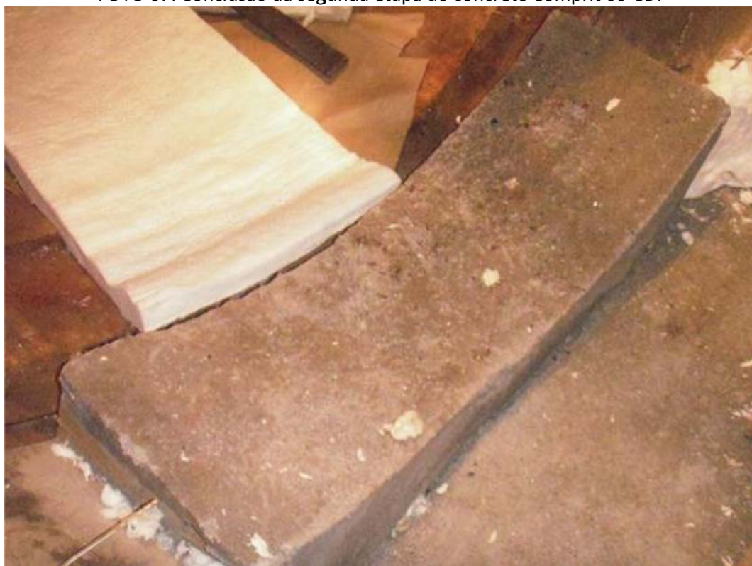
FOTO 08: Detalhe para a soleira em concreto refratário.
