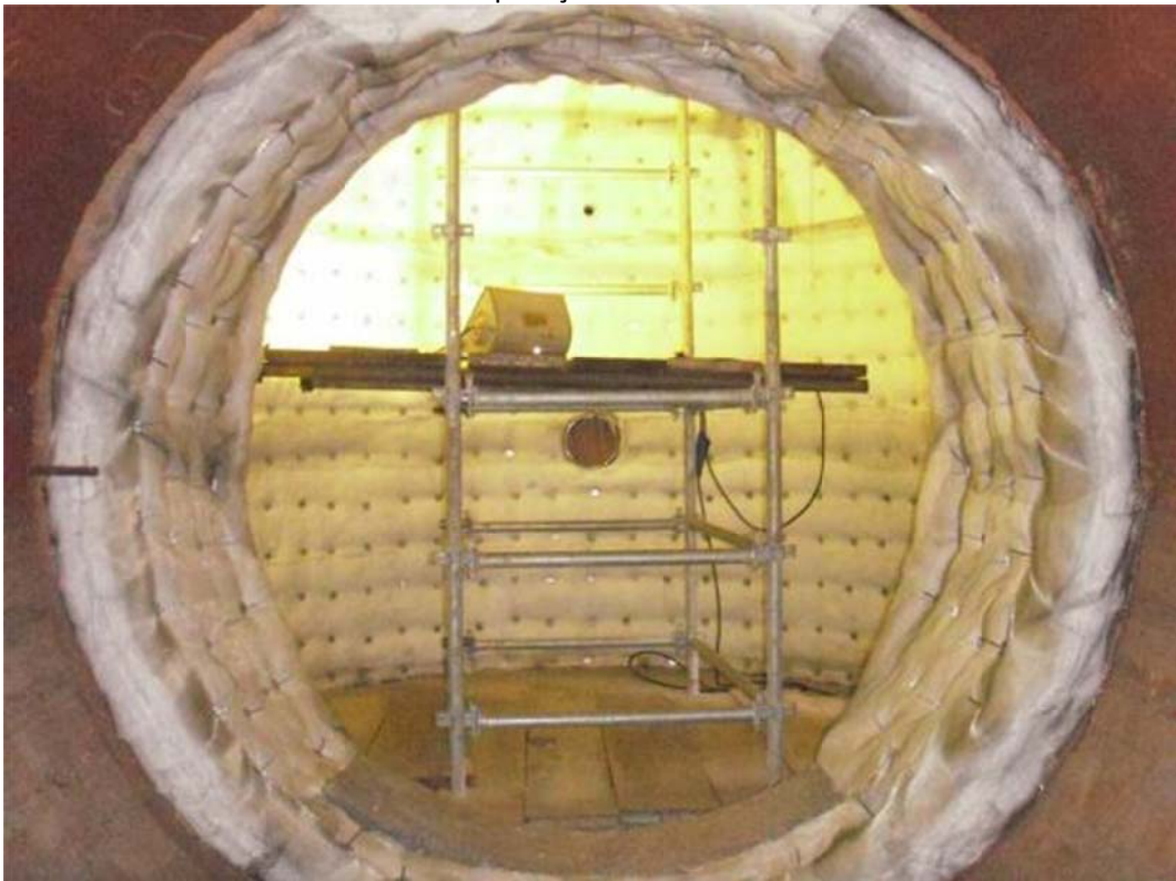
FOTO 21: Costado do P-1110 com a aplicação de manta cerâmica Durablanket concluída.
