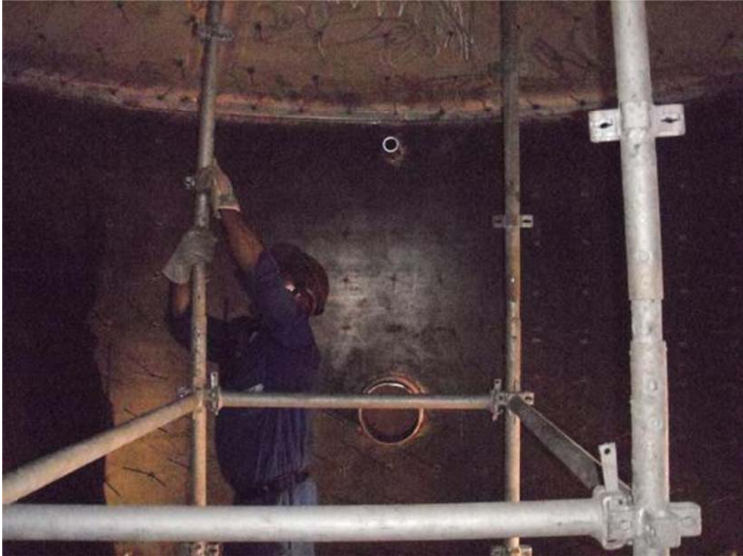
FOTO 09: Montagem do andaime para apoio na aplicação de manta cerâmica.
