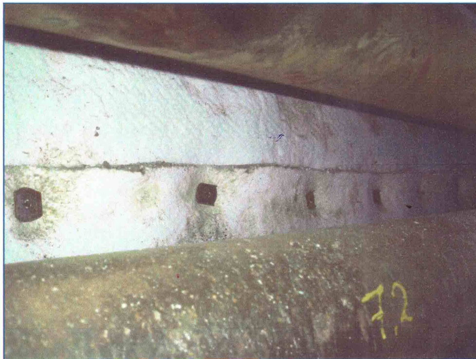
FOTO 2 – FIXAÇÃO DAS ARRUELA DE FIXAÇÃO
