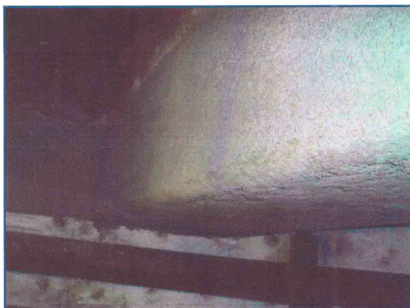
FOTO - 4 - CONCRETO LANÇADO POR DERRAMENTO NA REGIÃO INTERNA DO FORNO.
