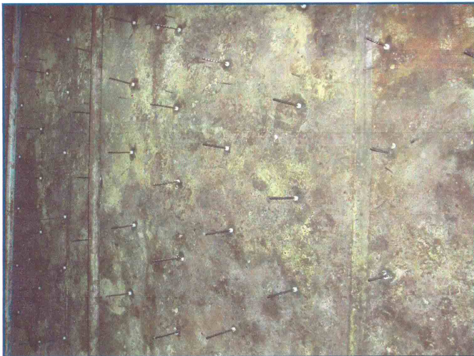
FOTO 1 – SOLDAGEM DOS PINOS DE FIXAÇÃO (TETO)
