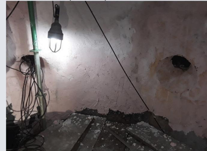
Remoção dos tijolos refratários e demolição do revestimento de massa plástica nos bocais
