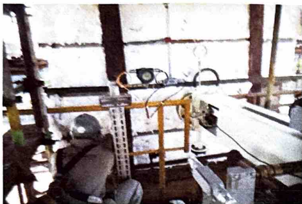
FOTO 07: RECOMPOSIÇÃO DO ISOLAMENO TÉRMICO VAPO's 03 e 04
