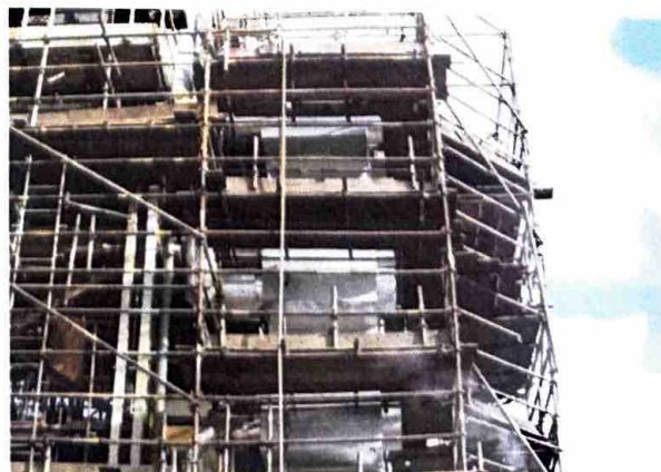
FOTO 18: RECOMPOSIÇÃO DO ISOLAMENO TÉRMICO VAPO's 03 e 04
