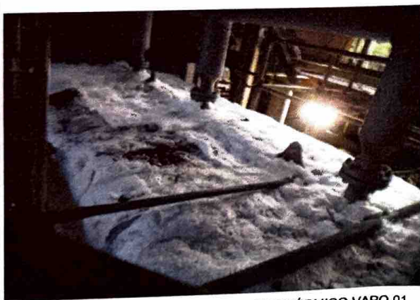
FOTO 3: RECOMPOSIÇÃO DO ISOLAMENO TÉRMICO VAPO 01
