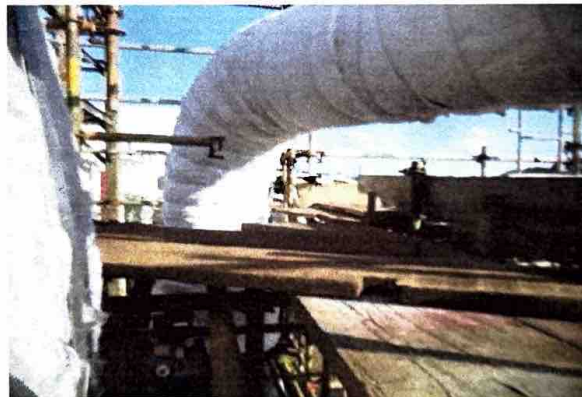
FOTO 10: RECOMPOSIÇÃO DO ISOLAMENO TÉRMICO TUBULÃO SUPERIOR DO VAPO 04
