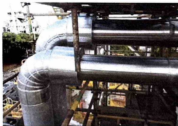
FOTO 16: RECOMPOSIÇÃO DO ISOLAMENO TÉRMICO TUBULÃO SUPERIOR DO VAPO 04
