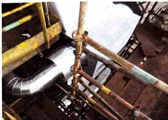
FOTO 14: RECOMPOSIÇÃO DO ISOLAMENO TÉRMICO VAPO's 03 e 04
