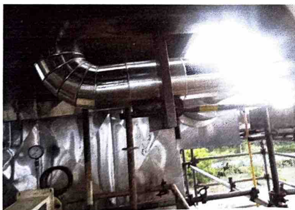
FOTO 15: RECOMPOSIÇÃO DO ISOLAMENO TÉRMICO VAPO's 03 e 04
