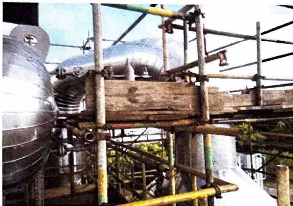
FOTO 13: RECOMPOSIÇÃO DO ISOLAMENO TÉRMICO TUBULÃO SUPERIOR DO VAPO 04
