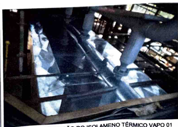
FOTO 5: RECOMPOSIÇÃO DO ISOLAMENO TÉRMICO VAPO 01
