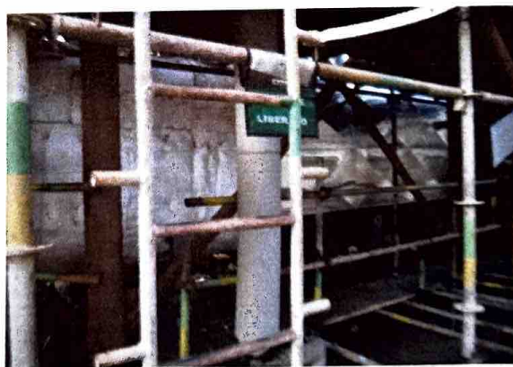
FOTO 4: RECOMPOSIÇÃO DO ISOLAMENO TÉRMICO VAPO 01
