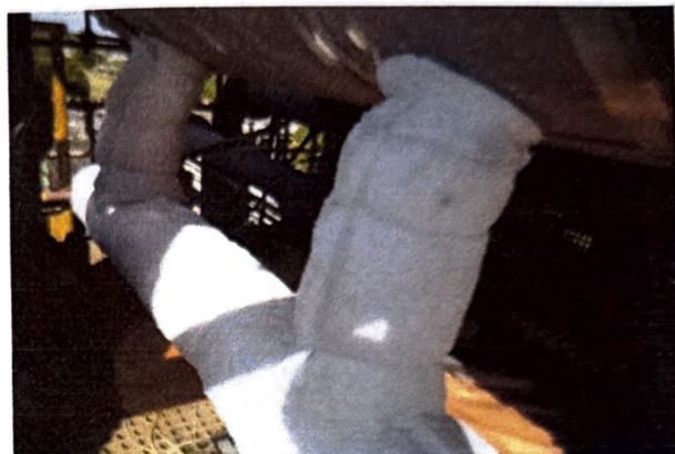
FOTO 20: RECOMPOSIÇÃO DO E203ISOLAMENO TÉRMICO NOS COLETORES DO TUBULÃO SUPERIOR DA GV
