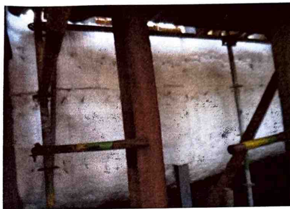
FOTO 2: RECOMPOSIÇÃO DO ISOLAMENO TÉRMICO VAPO 01
