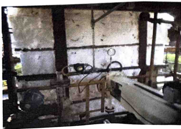
FOTO 11: RECOMPOSIÇÃO DO ISOLAMENO TÉRMICO VAPO's 03 e 04
