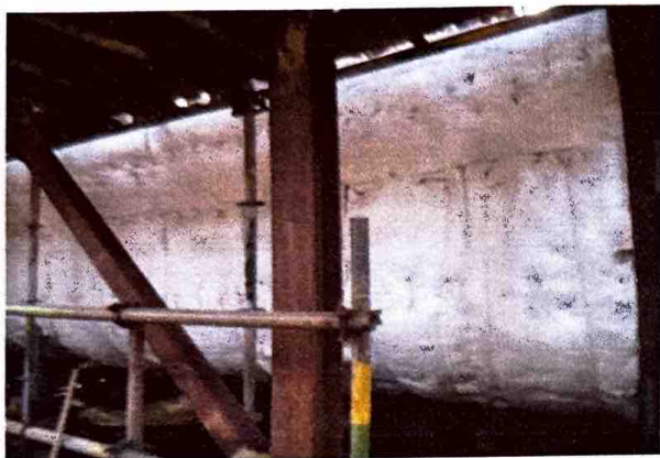
FOTO 1: RECOMPOSIÇÃO DO ISOLAMENO TÉRMICO VAPO 01
