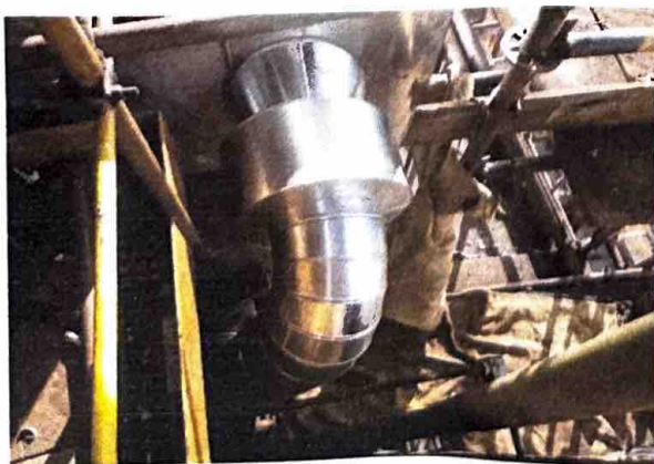
FOTO 17: RECOMPOSIÇÃO DO ISOLAMENO TÉRMICO VAPO's 03 e 04
