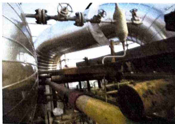
FOTO 12: RECOMPOSIÇÃO DO ISOLAMENO TÉRMICO TUBULÃO SUPERIOR DO VAPO 04
