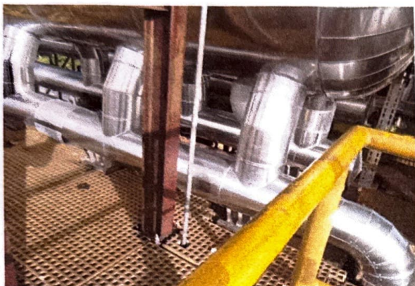
FOTO 19: RECOMPOSIÇÃO DO ISOLAMENO TÉRMICO NOS COLETORES DO TUBULÃO SUPERIOR DA GV
