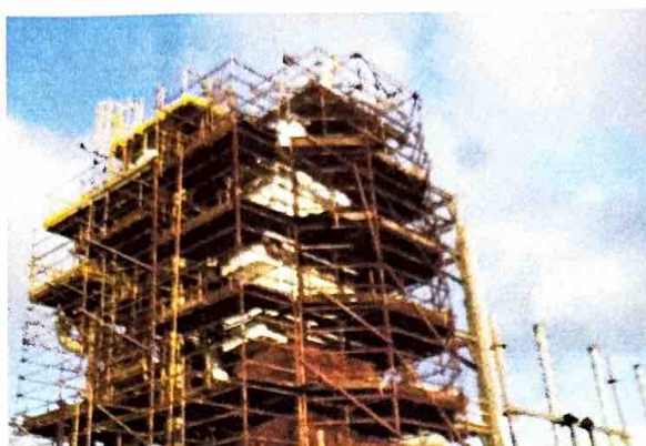
FOTO 08: RECOMPOSIÇÃO DO ISOLAMENO TÉRMICO VAPO's 03 e 04
