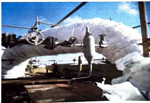
FOTO 09: RECOMPOSIÇÃO DO ISOLAMENO TÉRMICO TUBULÃO SUPERIOR DO VAPO 04
