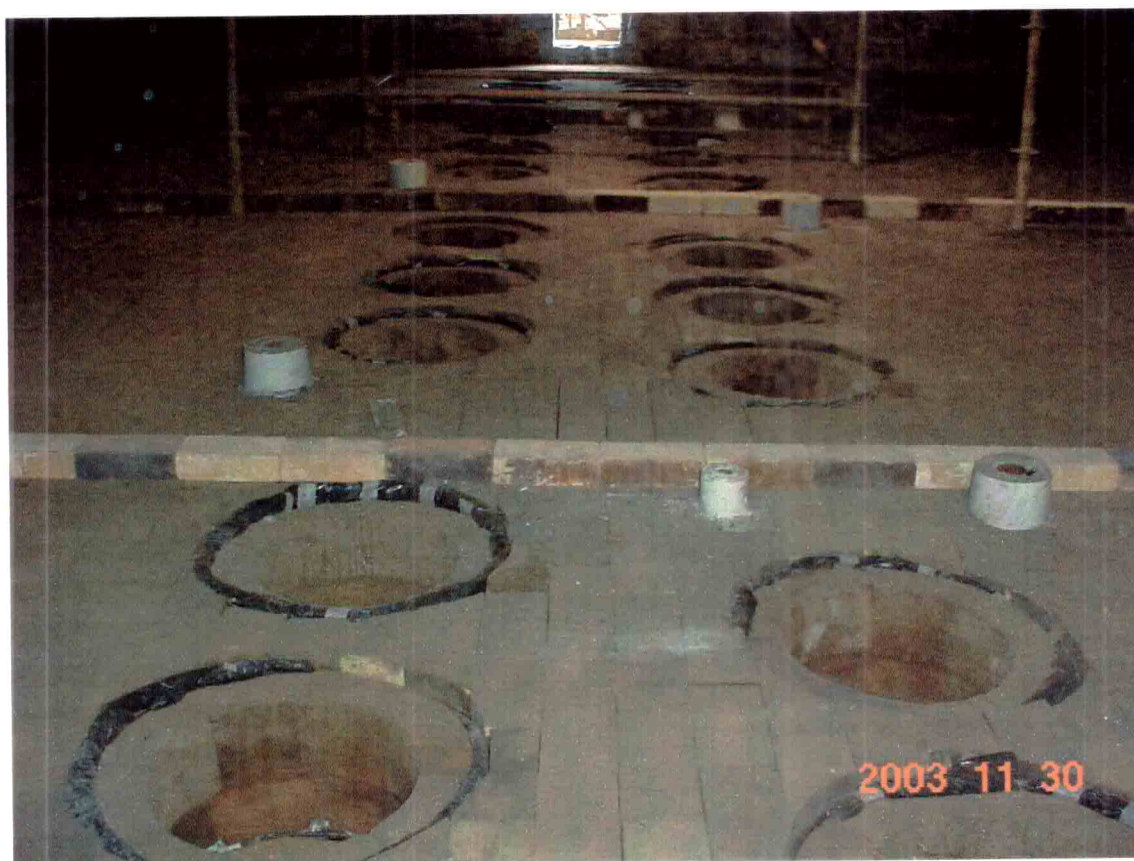
Conclusão do piso da radiação no B-3202.B
