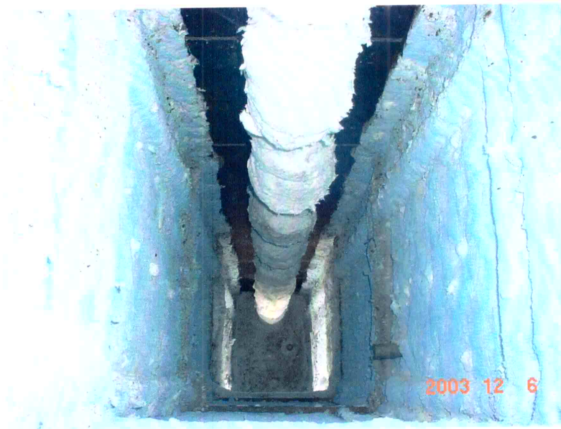
Aplicação de manta cerâmica nas caixas de curvas e serpentinas
