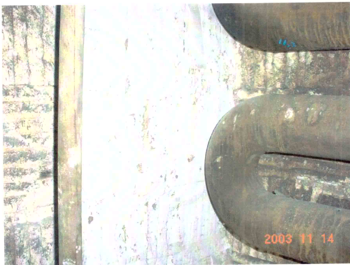
B-3201: Módulo cerâmico / e = 50 mm / Densidade: 160 kg/m 3
