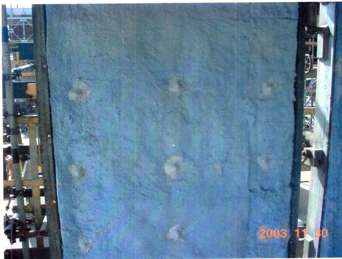
Aplicação de LDS nas ancoragens e de enrijecedor sobre a manta cerâmica
