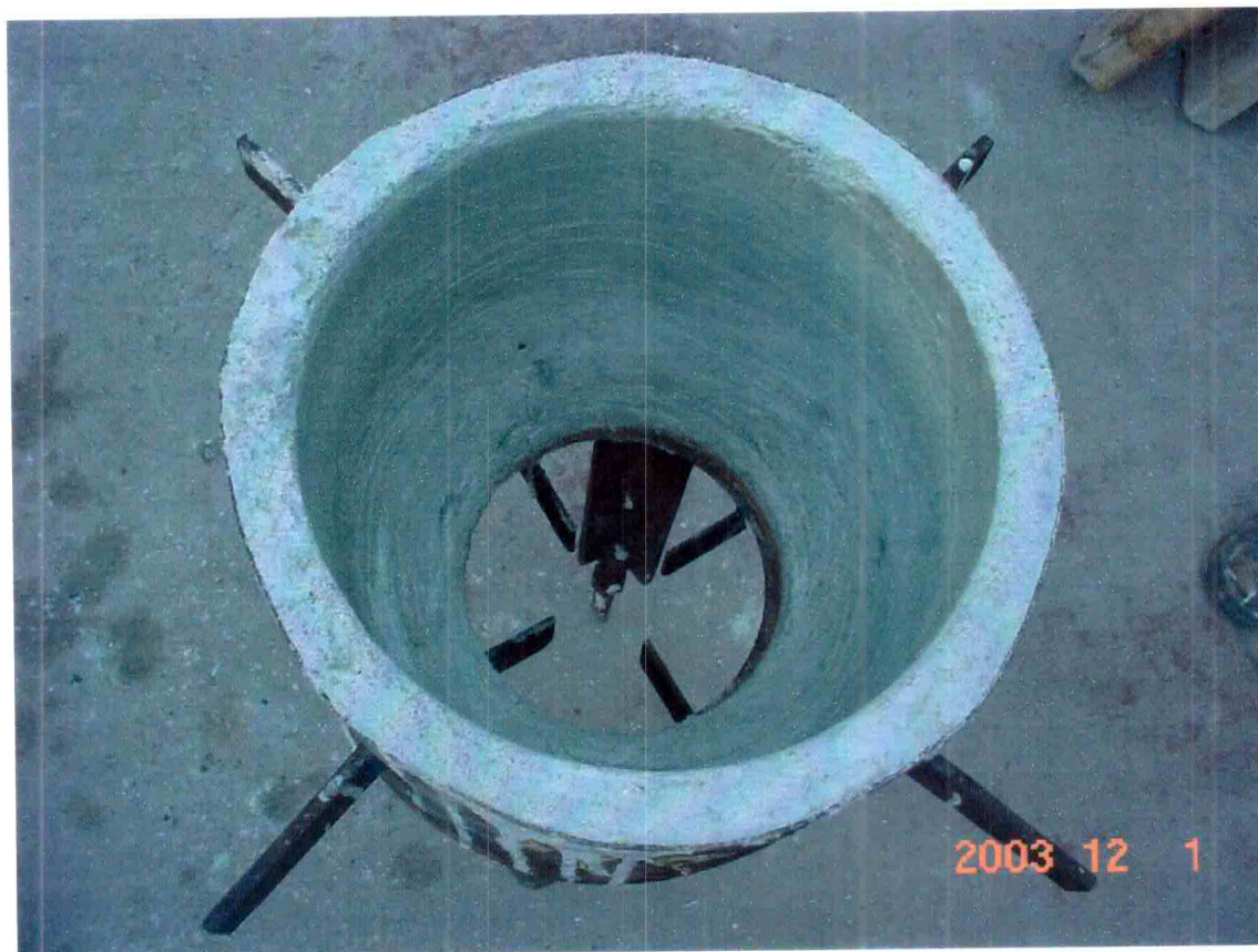
Fabricação dos blocos primários do B-3201 / B-3202 A e B / B-3203 A e B
