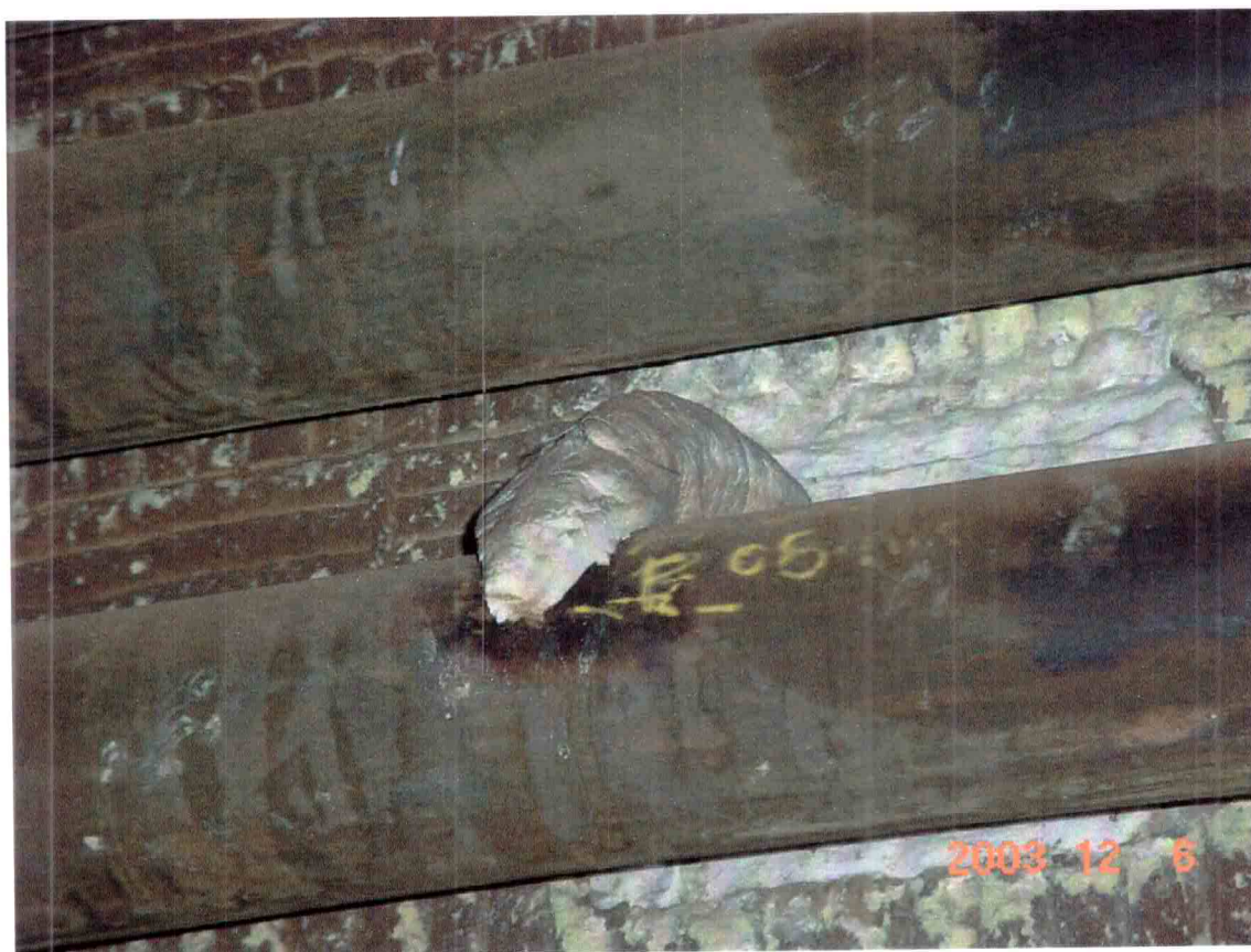
Aplicação de manta úmida na região dos "Skin-points"
