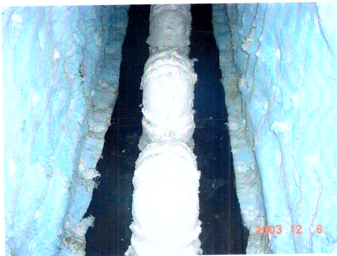
Aplicação de manta cerâmica nas caixas de curvas e serpentinas
