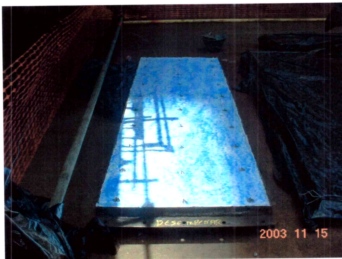
Aplicação de manta de fibra cerâmica e enrijecedor no B-3201
